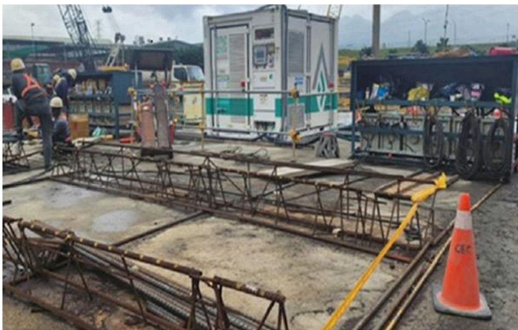
北機廠設置淨能櫃使用於連續壁鋼筋籠電焊機
