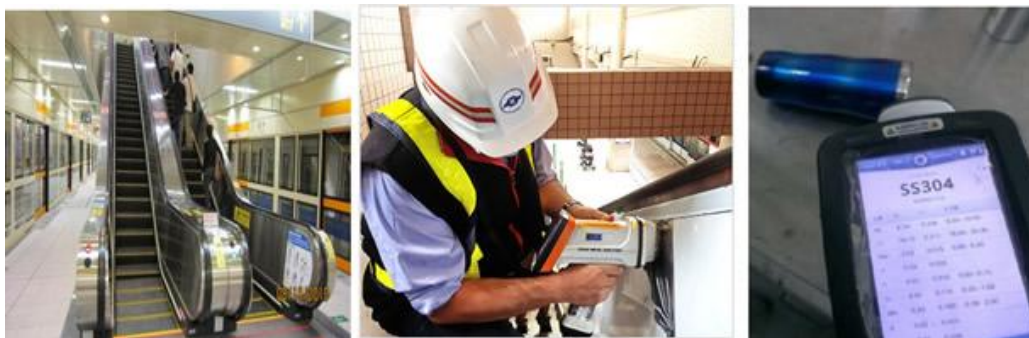
圖5 手持式金屬分析儀於工地現場執行不銹鋼材料檢測
