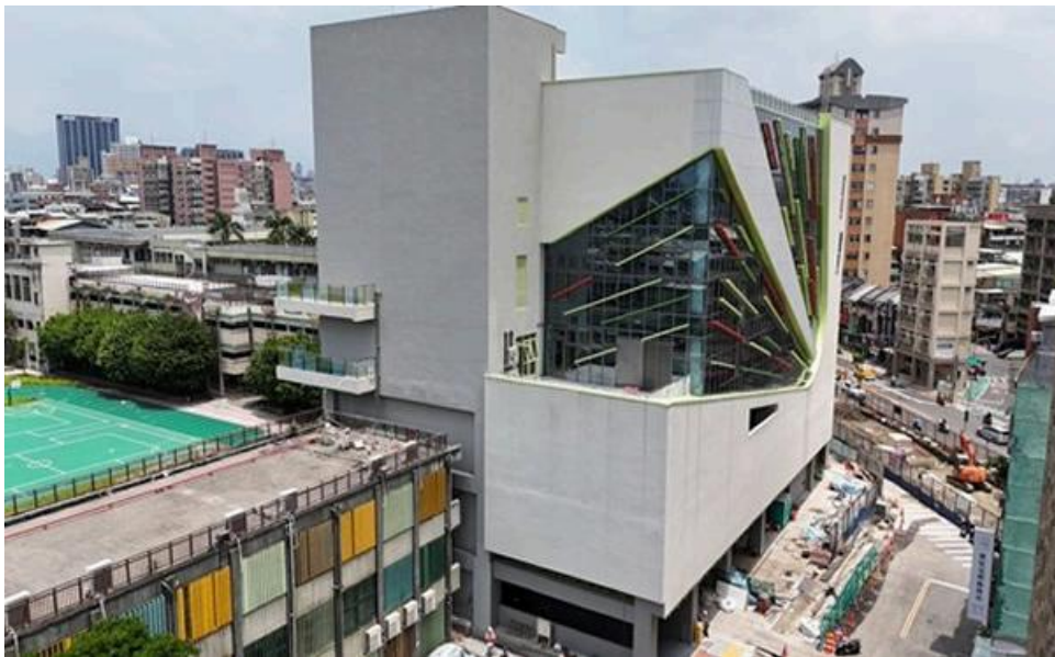
圖1 東園國小捷運共構大樓外觀（西北側）
