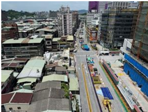
圖1 CQ860區段標工程鳥瞰照片
