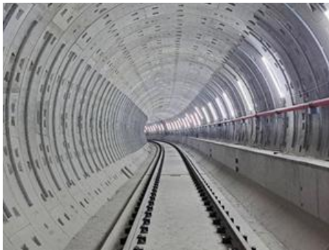
圖2 CQ860區段標工程潛盾隧道照片
