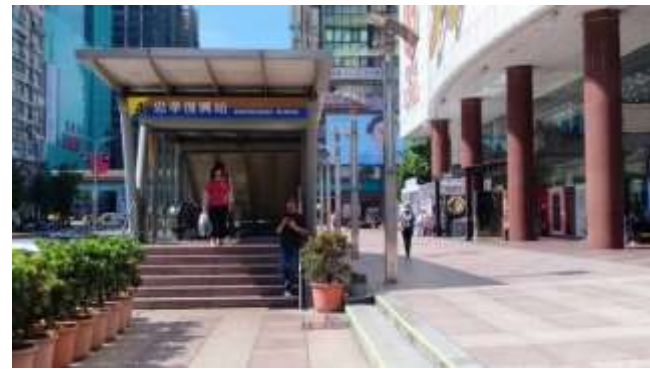
施工前照片（忠孝復興站 4 號出入口）
