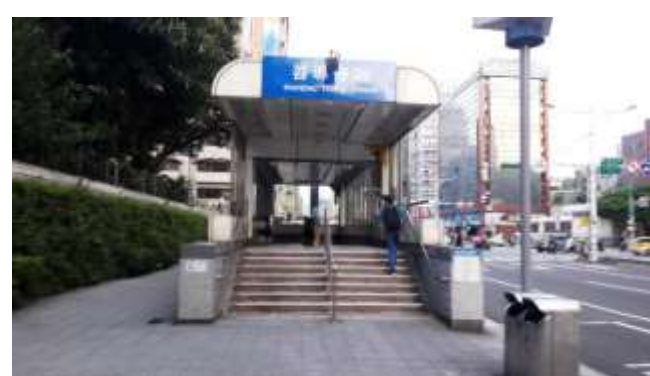
施工前照片 (善導寺站 1 號出入口)
