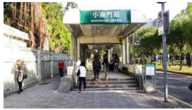
施工前照片（小南門站 1 號出入口）
