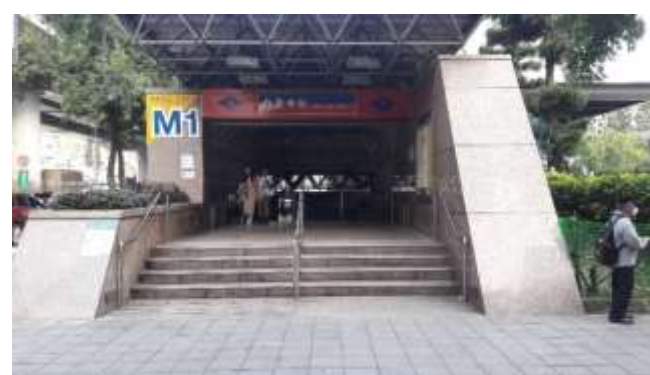
施工前照片 (臺北車站 M1 號出入口)
