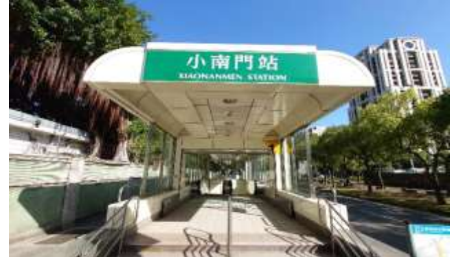
啟用後照片（小南門站 1 號出入口）
