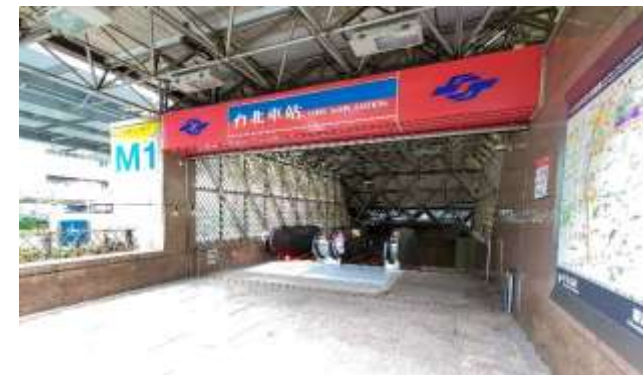
啟用後照片 (臺北車站 M1 號出入口)
