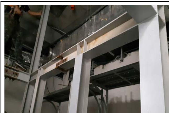
新蘆線 O13 站電梯鋼構組立
