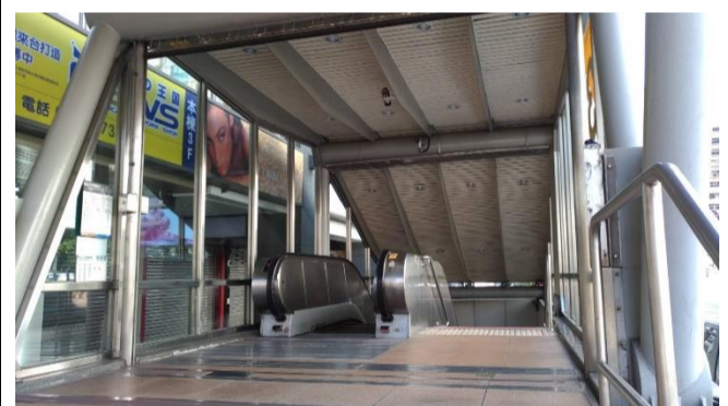
施工前照片（忠孝復興站）
