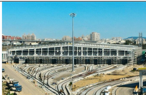
臺中線 CJ910 區段標主維修場前扇形區軌道道岔施工
