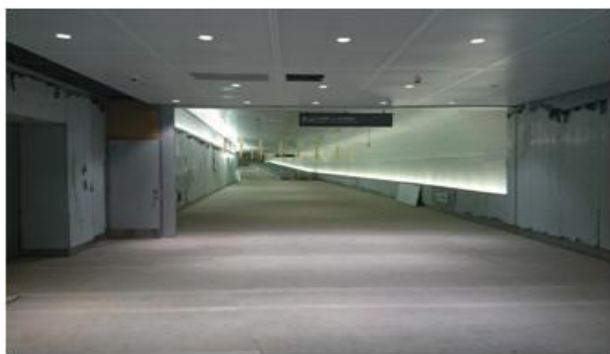
桃園機場線 A1 站機場線通往松山線北門站連通道
