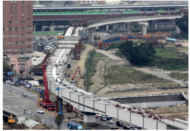
臺中線 CJ930 區段標 G12 站~G13 站間轉彎段施工現況
