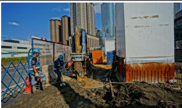
環狀線第一階段 CF660 區段標施工情形
