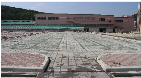
新莊線 CK570J 標新莊機廠轉乘停車場 混凝土磚鋪設
