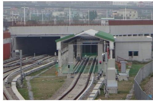
臺中都會區大眾捷運系統烏日文心北屯線 CJ910 標_北屯機廠_洗車廠現況
