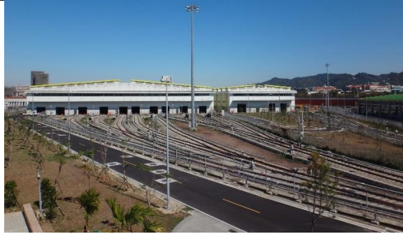
臺中都會區大眾捷運系統烏日文心北屯線 CJ910標 北屯機廠 主維修廠現況
