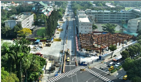
萬大中和樹林線(第一期工程) 植物園站國語實小共構大樓工區鳥瞰圖
