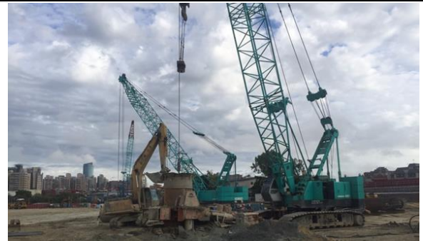
萬大中和樹林線(第一期工程) 金城機廠 基樁施作
