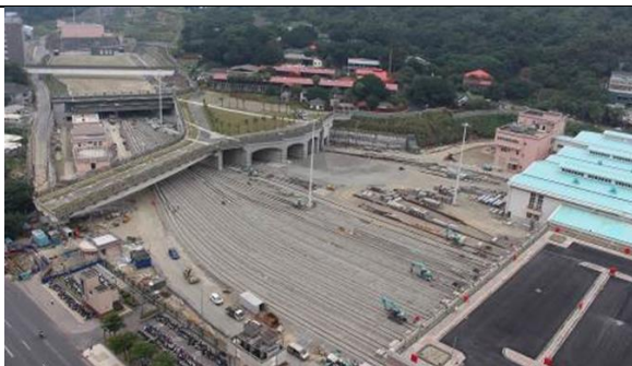
新莊線CK570J標 新莊機廠工區現況
