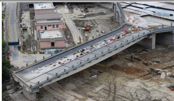
新莊線CK570J標 新莊機廠工區現況
