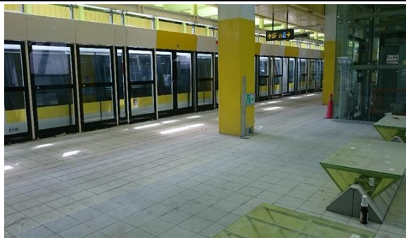
環狀線第一階段CF640區段標 Y7高架車站月台層現況
