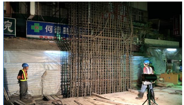
萬大中和樹林線(第一期工程) CQ860區段標連續壁鋼筋籠吊放
