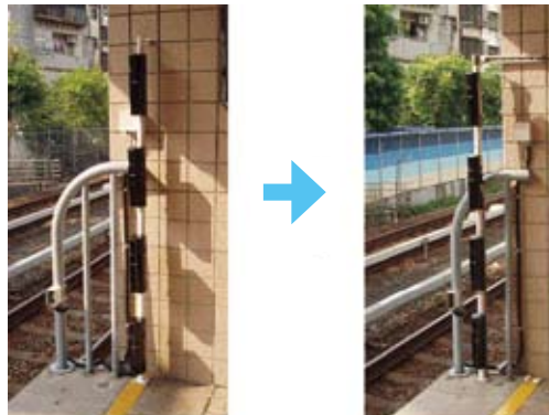
↑ 圖 13・月台警戒線偵測器調整情形
