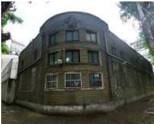
臺北市市定古蹟大稻埕變電所
