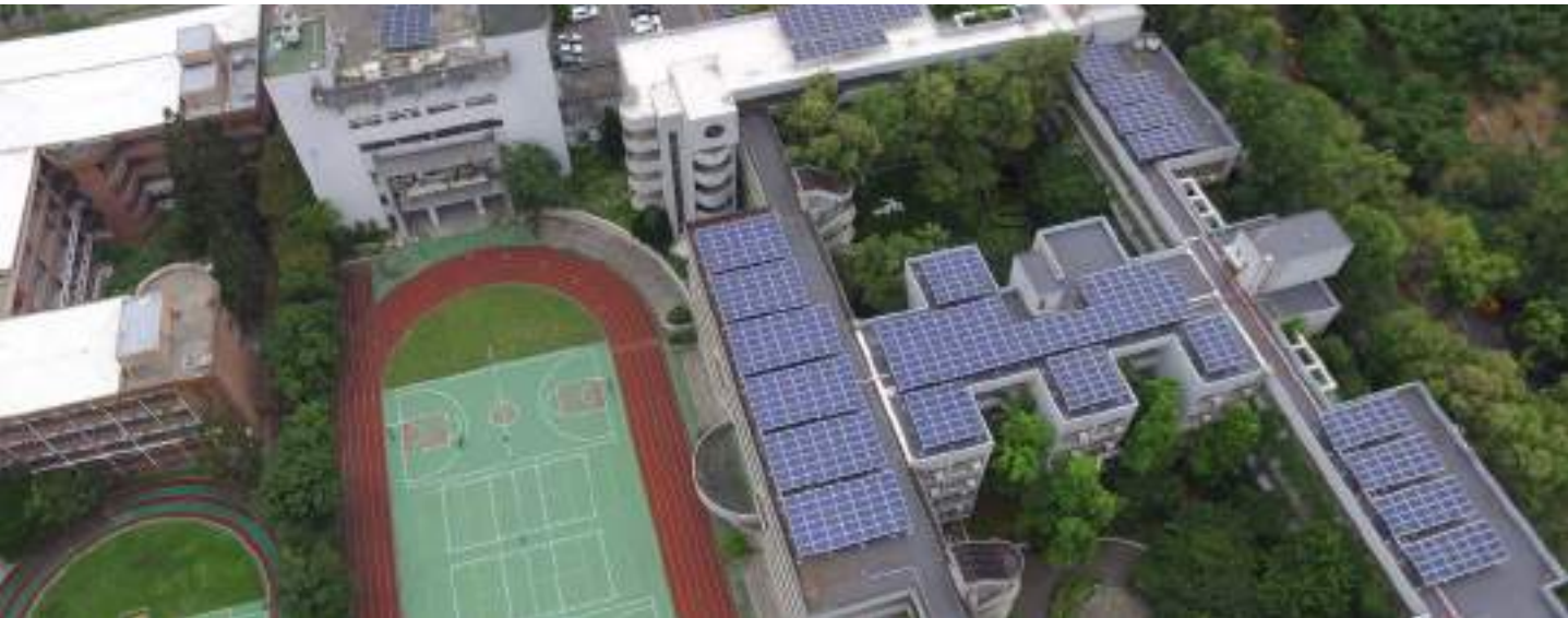
天母國中太陽光電設置容量 424.8 瓩
