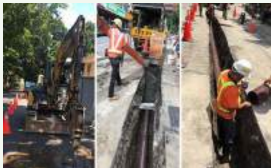
溫泉管線維修汰換
