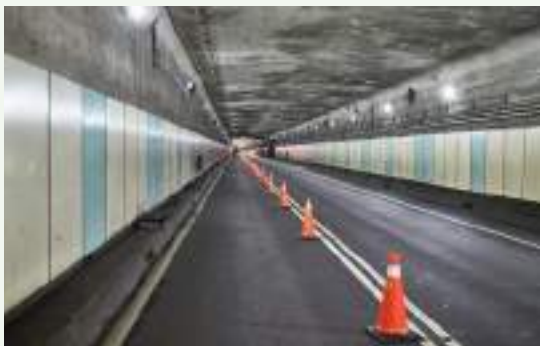
林森南路車行地下道更換 LED 燈，視野更清晰
