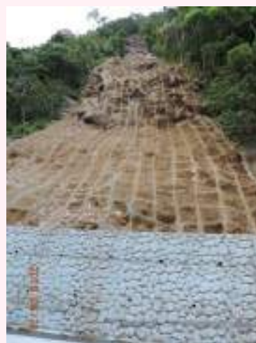
水庫邊坡型框植生整治
