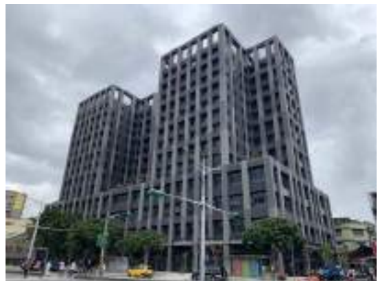
大龍社區及市場重建工程現況
