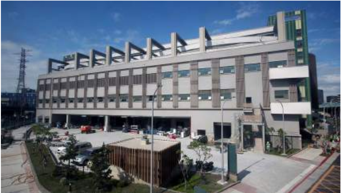
環南市場改建工程第 1 期工程現況
