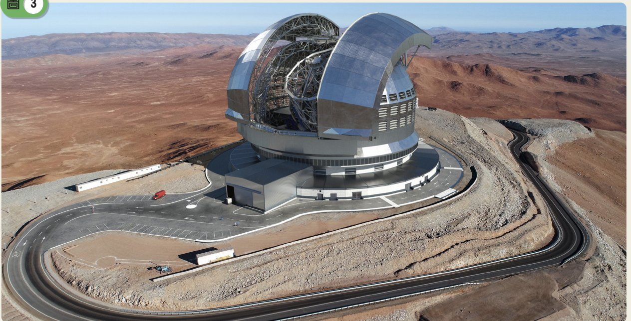
最新一代的地面望遠鏡-極大望遠鏡完工想像圖，考量建造成本及望遠鏡的重量，現今的大型地面望遠鏡均採用反射式望遠鏡的設計。圖片來源：ESA
