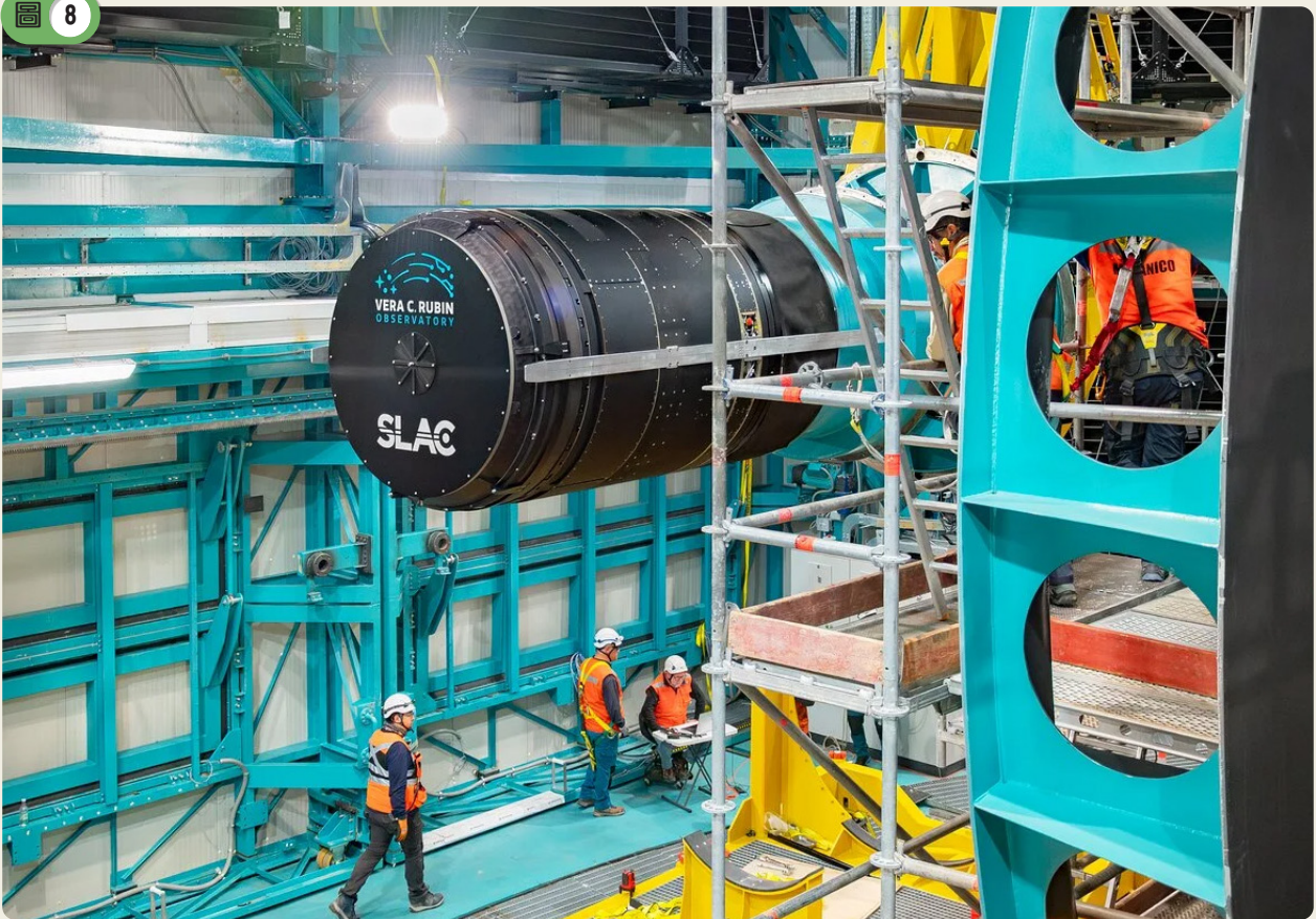
在薇拉·魯賓天文臺中進行安裝工程的LSST數位相機，此相機是目前全球大型天文臺中最大的相機，將提供超高靈敏度、解析度，以及寬廣視野的觀測影像。圖片來源：Rubin Observatory/NSF/AURA/B. Quint
