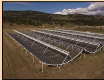
CHIME使用之天線 天線增益:2-10dBi 偵測波段:400-800MHz
