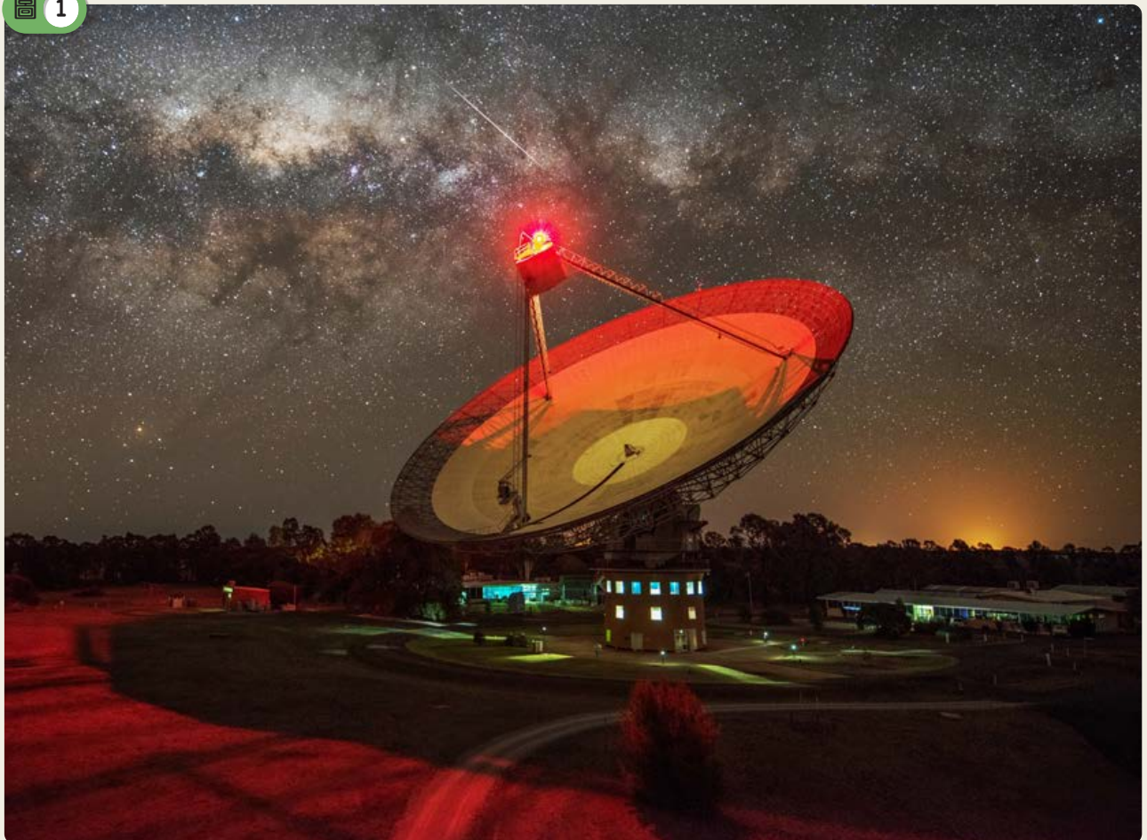
第一個發現FRB訊號的澳洲帕克斯電波望遠鏡，口徑為64公尺，觀測範圍為700MHz~4GHz，主要用途為觀測FRB、脈衝星，以及研究宇宙背景輻射。影像來源：David McClenaghan CSIRO
