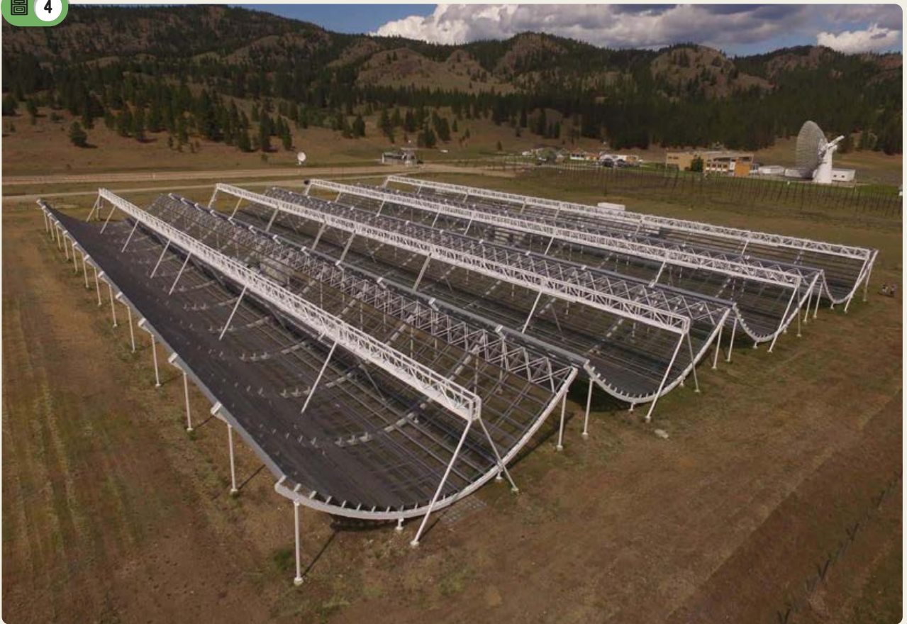
此為目前主要研究FRBs的加拿大CHIME陣列電波望遠鏡，觀測波段範圍為400MHz~800MHz，最初設計為觀測、研究宇宙微波背景輻射，由四個長達100公尺的拋物線圓柱體所組成。影像來源：CHIME
