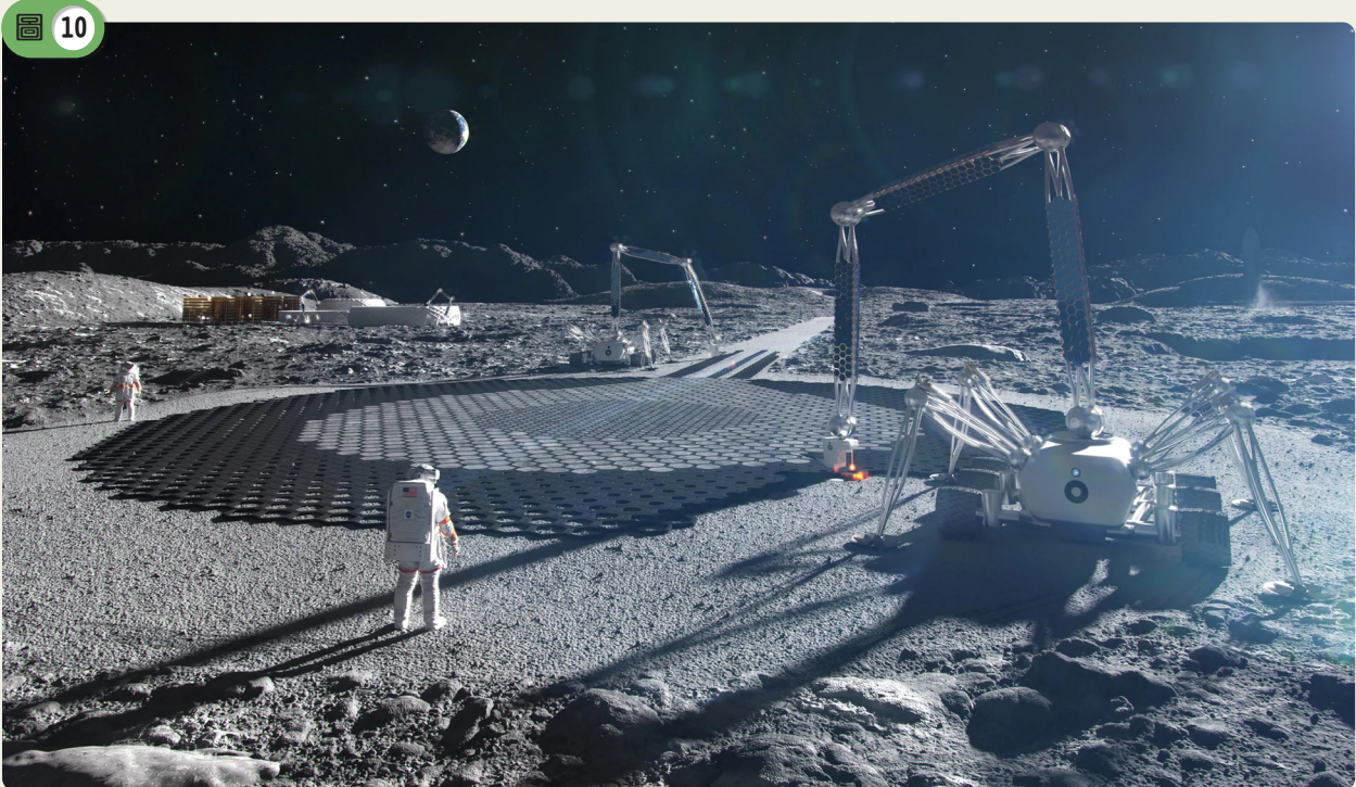
太空人運用設計在月球環境使用的土木工程機具，進行月球基地的地基與道路鋪設工程示意圖。影像來源：NASA/ICON
