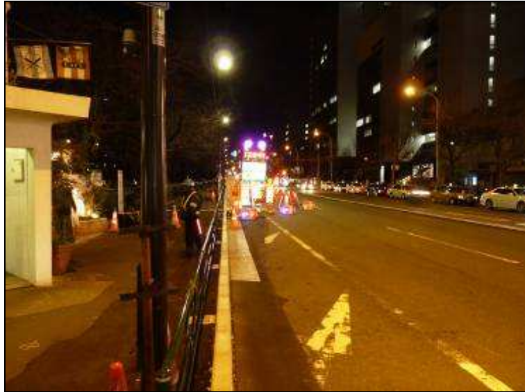
圖94 道路夜間施工之指引設施（照明清楚及設置1名交通引導人員）。
