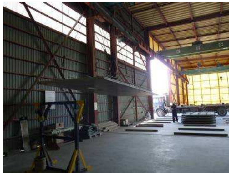
圖44 以天車進行版片吊運作業。
