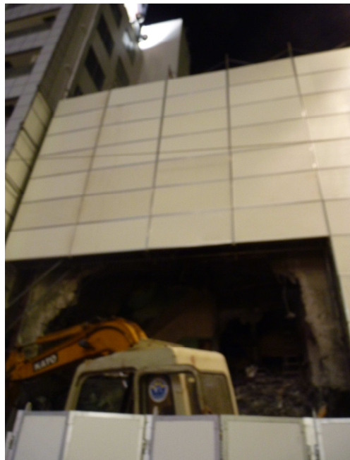
圖98 拆除工程之施工防護圍籬（密閉乾淨）。
