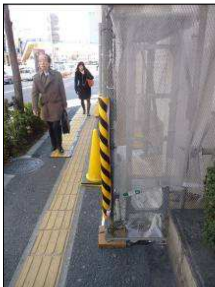
圖73 裝修工程針對行人通道轉角加裝防護措施（轉角防護避免路人碰觸受傷）。
