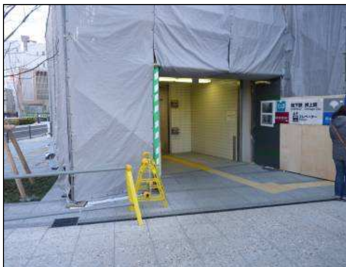
圖96 地下鐵車站出口施工之防護措施（針對人潮較多之區域施工作業防護更加落實）。
