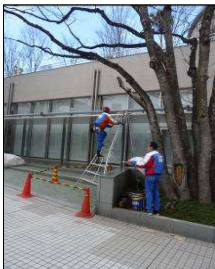
圖65 樹木修剪作業使用合梯及標示作業範圍（合梯作業採2人伙同作業，增加合梯使用之安全性）。
