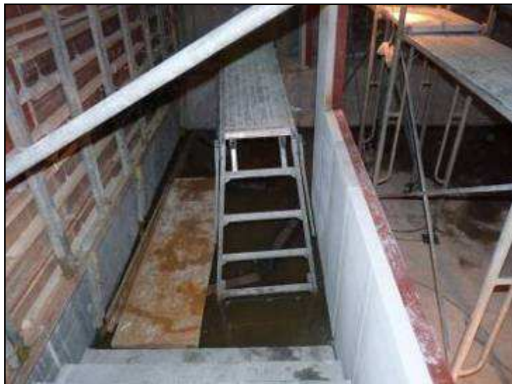
圖32 工地臨時作業使用之工作梯（國內多採用合梯）。
