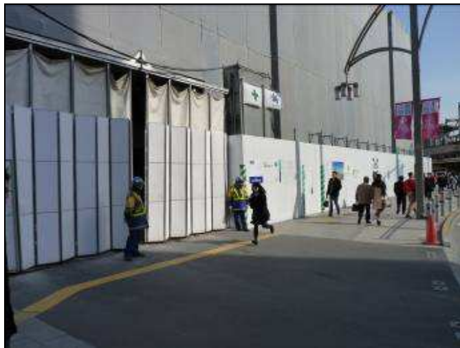
圖86 建築工地美觀之外牆施工圍籬及2名管制人員（管制人員設置2位皆站立於門口做交通引導及管制出入，與國內僅一名警衛負責更能達到成效）。
