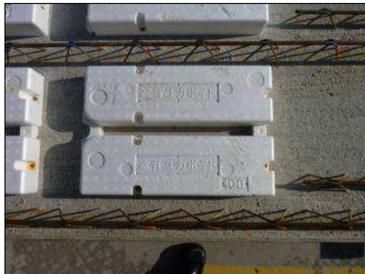
圖42 中空樓板使用之隔音材。
