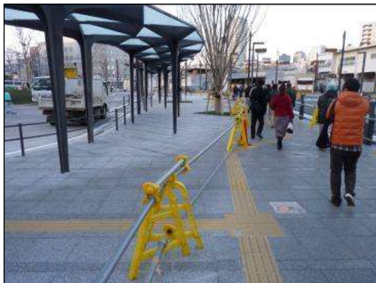
圖76 臨時性施工圍籬（方便穩固不易撞倒效果較國內使用之三角錐合宜）。
