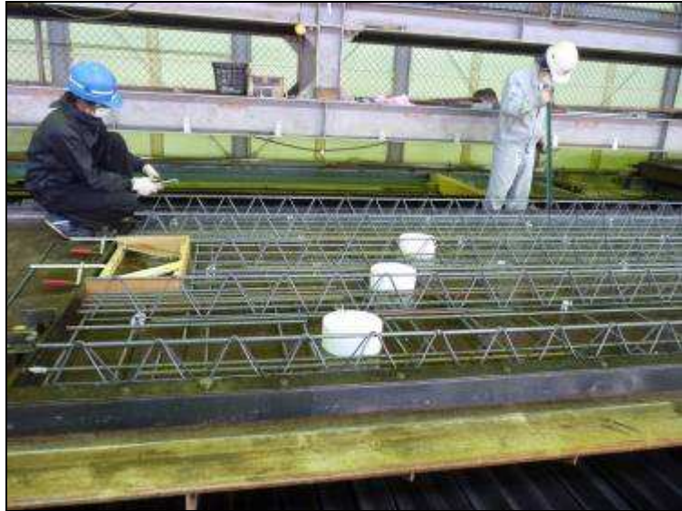
圖46 鋼筋綁紮作業。
