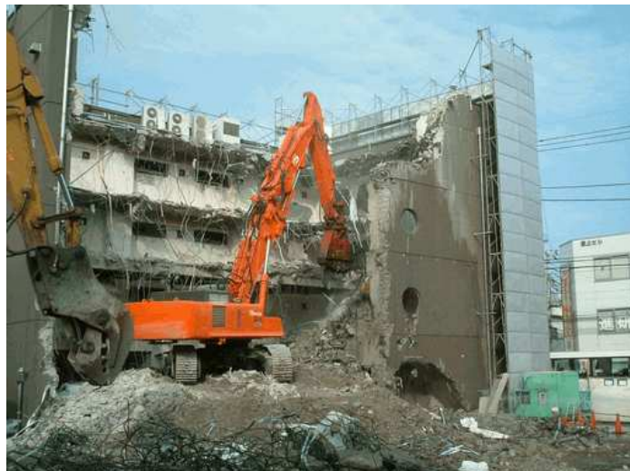
圖99 拆除工程之施工防護圍籬（密閉乾淨）。
