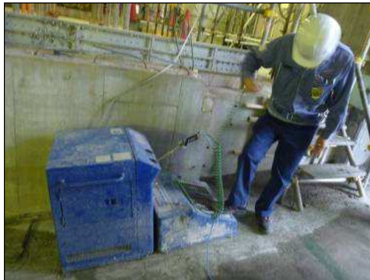
圖28 工地出口設置清潔衣物鞋面之機具（壓縮空氣噴槍）。
