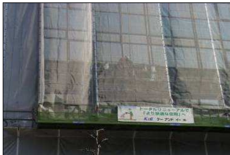
圖90 吊籠施作（吊籠外加防護網更能確保施工作業之安全）。
