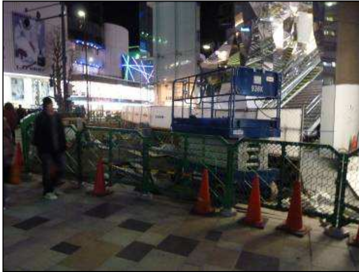
圖69 裝修工程臨時性圍籬明顯與行人區隔（裝修作業臨時性圍籬設置確實，行人不易誤闖）。
