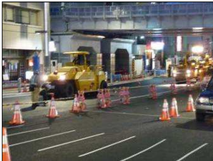
圖82 道路作業臨時性警告標示（設計可愛實用之警示錐同樣達到作業範圍明顯區隔）。
