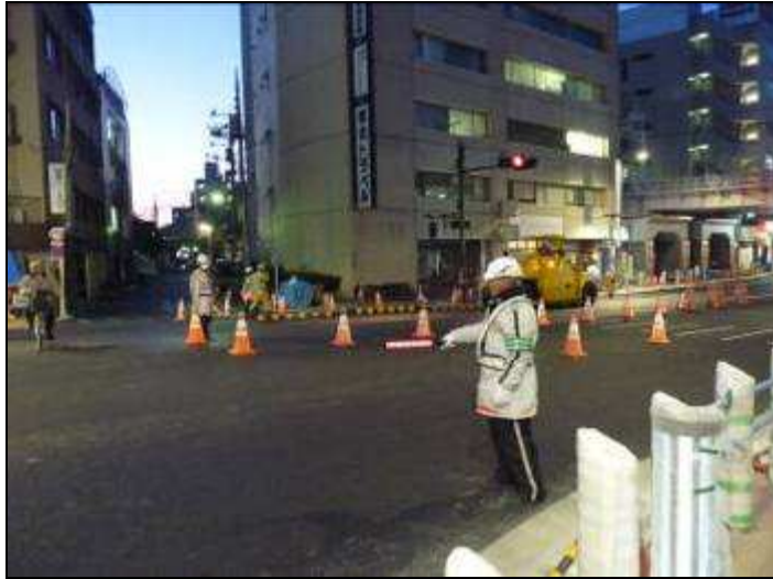
圖83 道路工程作業管制措施（作業起點及終點皆設置交通引導人員且引導人員個人防護具皆配備完善，與國內義交之配備有所不同）。
