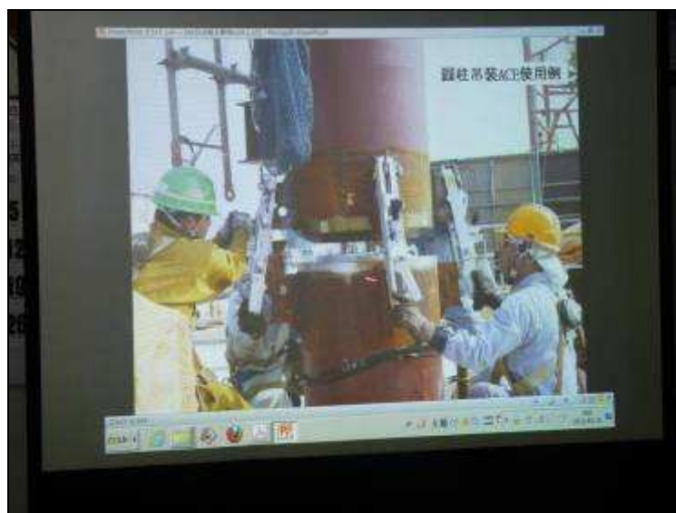
圖54 ACE-UP鋼構吊裝工法介紹。
