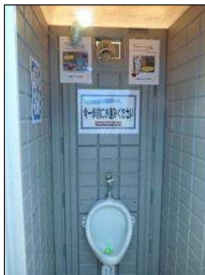
圖29 工地臨時洗手間張貼之安衛標語。
