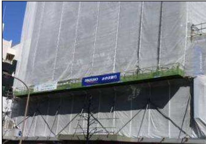
圖72 外牆整修作業防護措施（落實外牆防護避免作業物料掉落傷及勞工或路人）。
