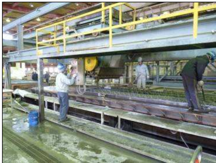
圖47 混凝土澆置作業（全面機械自動化）。
