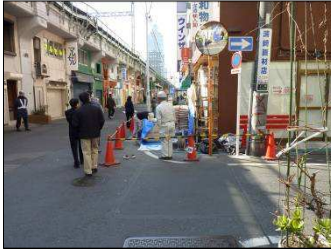
圖88 一般住家房屋補強工程之防護作法（作業範圍以警示錐區分並設置1名交通引導人員）。
