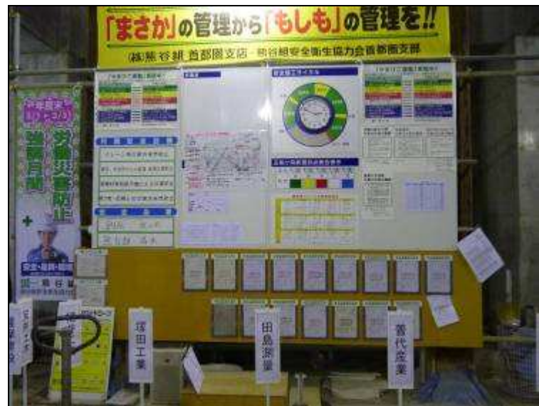
圖22 於工地地下室設置之每日安衛管理場所（含施作廠商、每日作業時程安排、每週防災重點、使用鋼索顏色管理等）。
