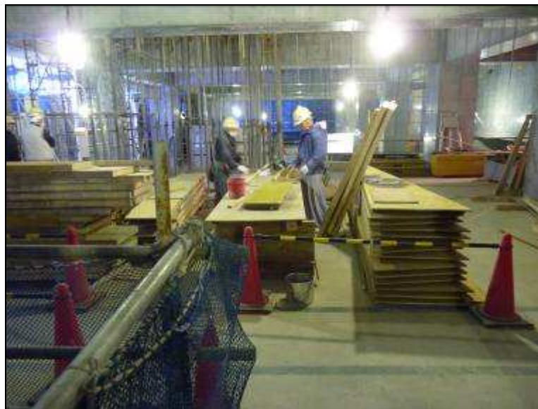
圖34 現場模板作業勞工之工作服裝（寬鬆舒適）。
