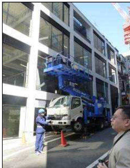
圖89 移動式工作車（外牆作業採工作車施工方式，安全且機動性高並確實指派1名交通引導人員負責引導交通）。
