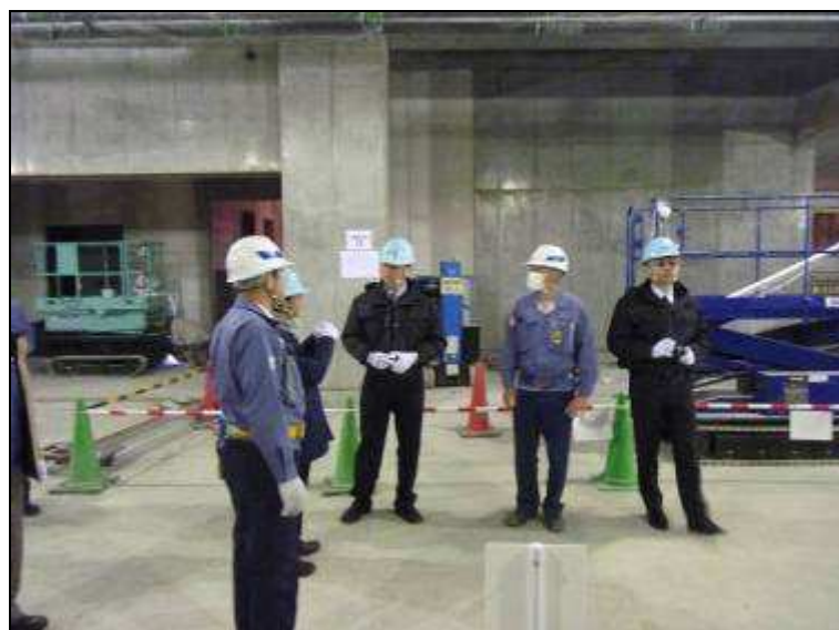
圖23 小久保所長詳細解說工地管理方式。
