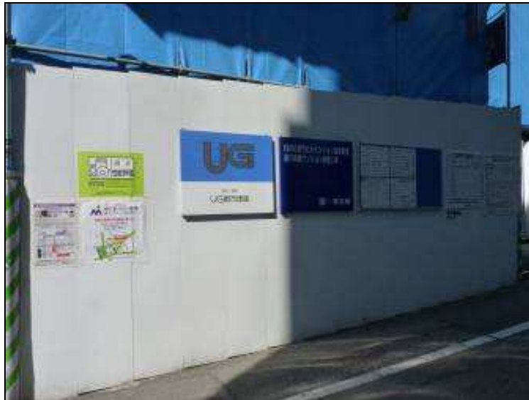
圖18 工地大門口施工圍籬公告之各項許可證及相關告示牌。
