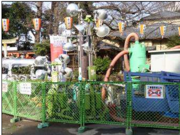
圖84 臨時性照明設備及臨時施工圍籬（移動式照明攜帶方便採立柱式更能達到照明效果）。
