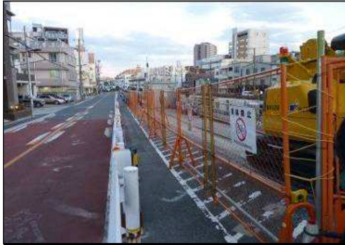
圖80 臨時性行人通道（設置三種圍籬搭配行人通道確實達到照顧行人之效果）。
