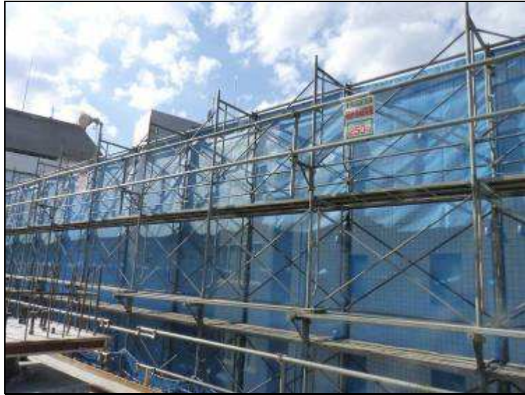
圖30 工地設置之外牆施工架明顯處標示最高荷重。
