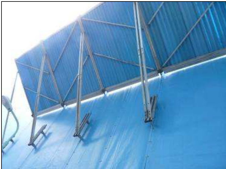
圖25 外牆施工圍籬使用可調式施工斜籬。
