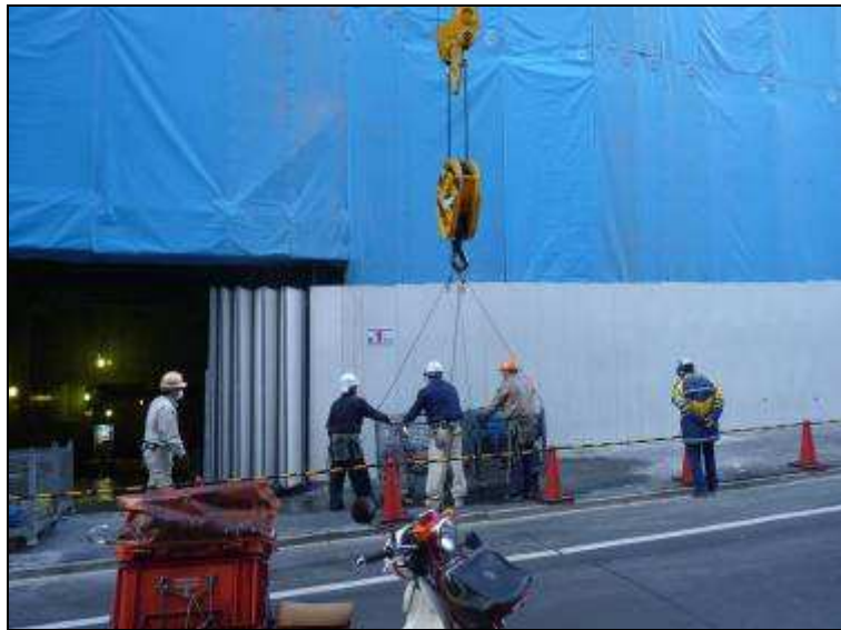
圖31 工地佔用道路吊裝作業設有監視人員及交通引導人員。
