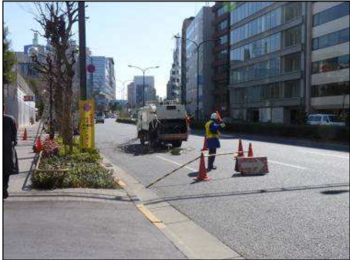
圖97 臨時道路作業之引導人員及設施（樹木裁剪作業仍未忽略設置交通引導人員）。
