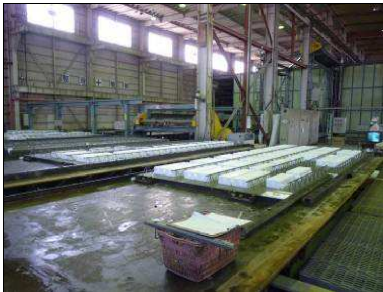
圖48 中空樓板隔音材置放。
