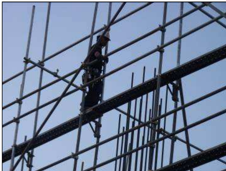
圖78 鋼管式施工架搭設作業（可適合各種不同寬度之搭設）。
