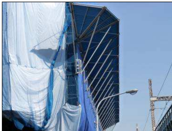
圖93 可調式施工斜籬（易於搭設調整位置減少勞工危險性作業）。
