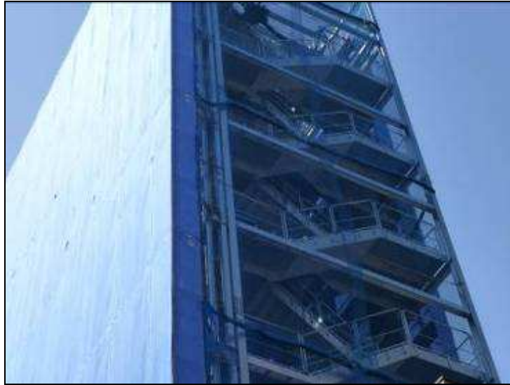
圖91 建築工地之鋼梯臨時性欄杆（鋼梯之護欄採以類似C型夾之固定方式方便組拆）。
