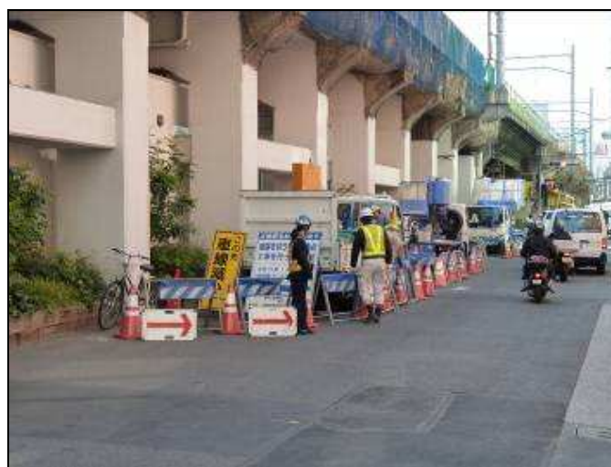
圖87 佔用道路作業設置之管制人員（臨時性佔用道路作業於起點及終點皆設置交通引導人員且引導標示清晰可見）。
