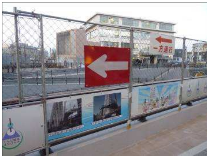
圖95 河岸作業之臨時施工圍籬（臨時施工圍籬搭配工程簡介達到宣導及美觀防護之效果）。
