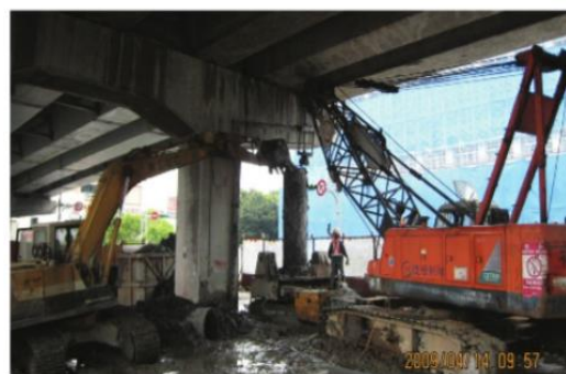
高架橋下淨空限制下(約7.5M)之基樁施工案例圖片
