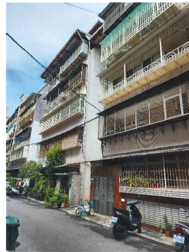
現況照片A：建築物側面(東南向)
