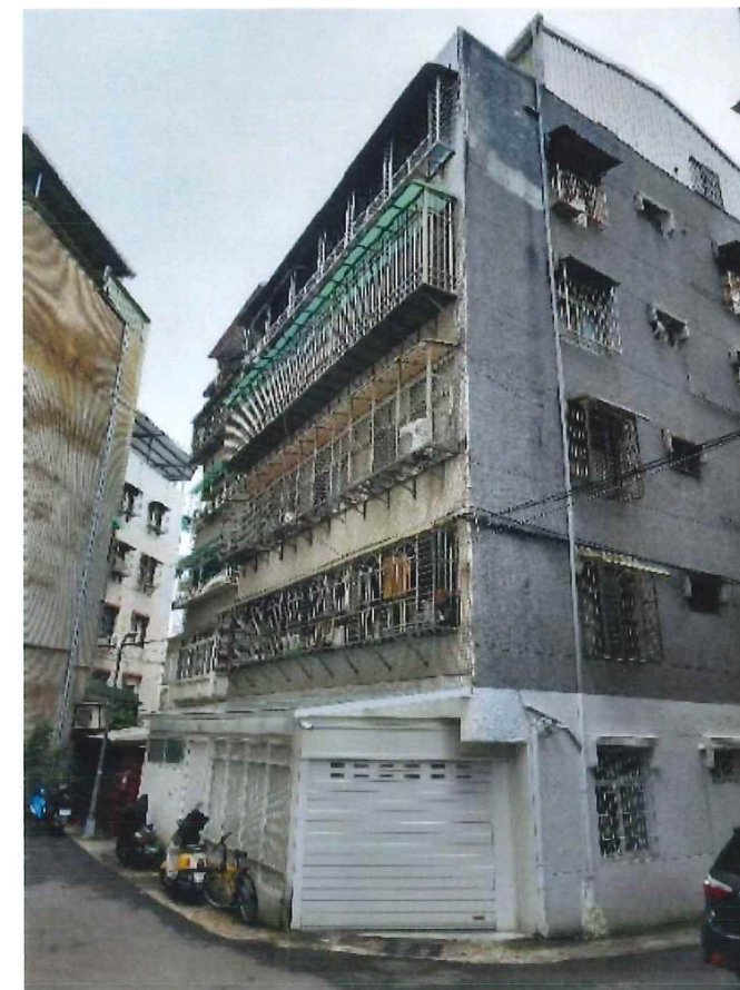
現況照片A：建築物北面中和街493巷1弄
