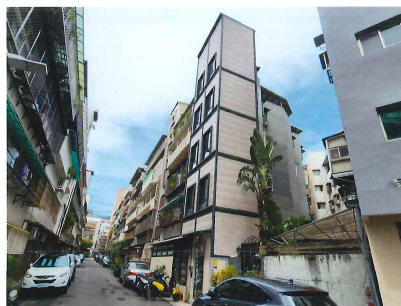
現況照片B：建築物南面面臨中和街493巷3弄
