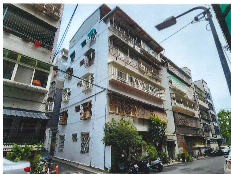
現況照片B：建築物側面(西南向)
