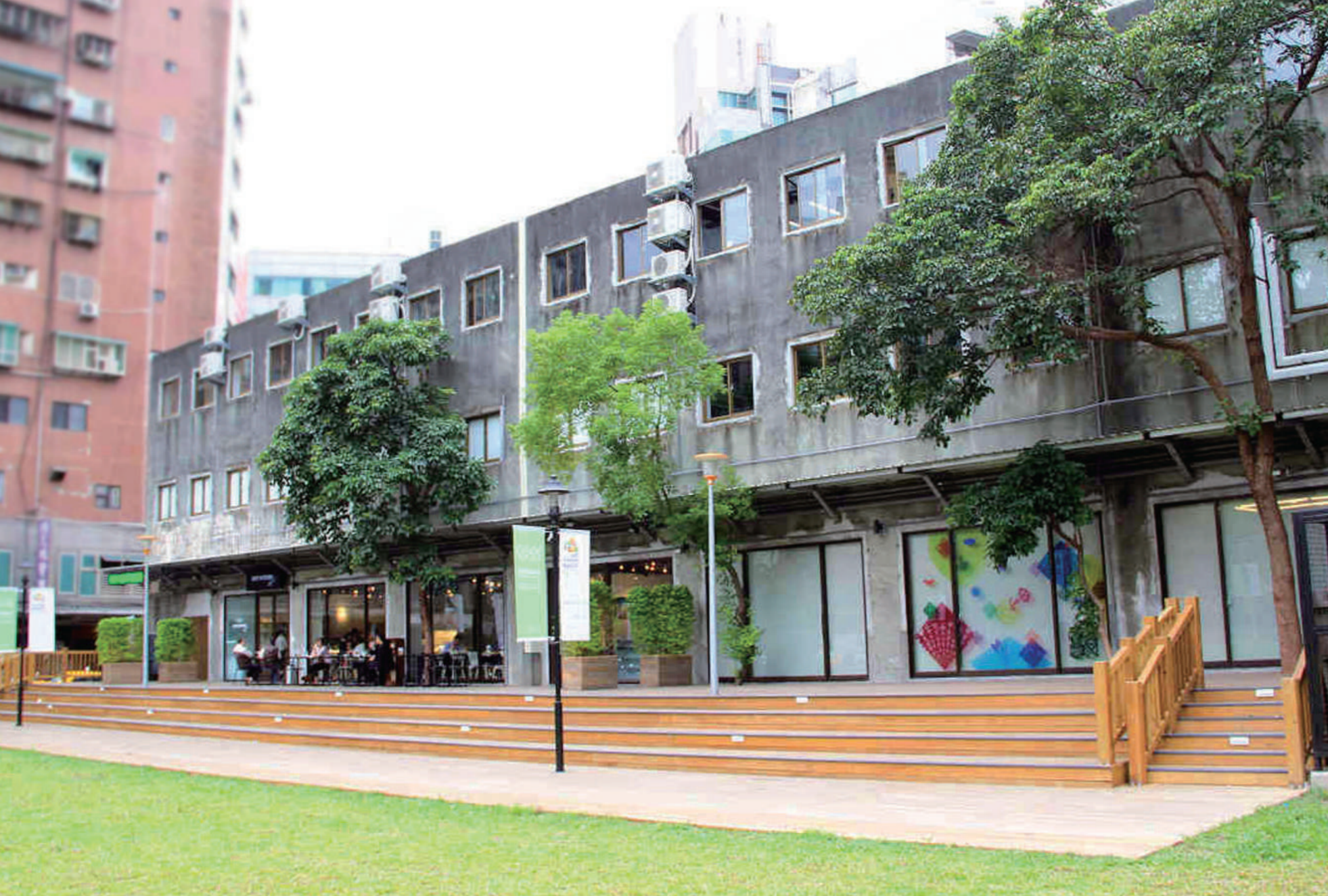
▲ 一樓室外前方為公共藝術廣場
