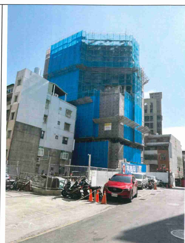
3 基地範圍臨北側未開闢計畫道路之一景
