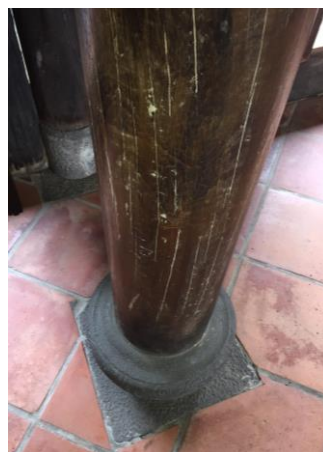
【圖 3-41】四點金柱採用烏心石木材 資料來源：本所拍攝
