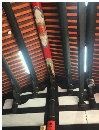
【圖 3-65】正廳採用穿斗式斗拱架構 【圖 3-66】正廳上方的大樑 資料來源：本所拍攝 資料來源：本所拍攝。
