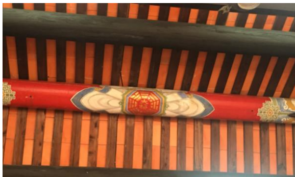
【圖 3-65】正廳採用穿斗式斗拱架構 【圖 3-66】正廳上方的大樑 資料來源：本所拍攝 資料來源：本所拍攝。
