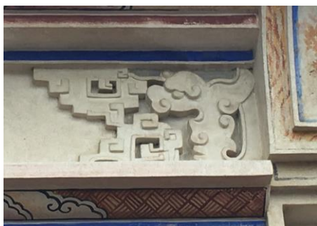
【圖 3-37】門廳牆面及簷口之夔龍浮飾石雕 資料來源：本所拍攝
