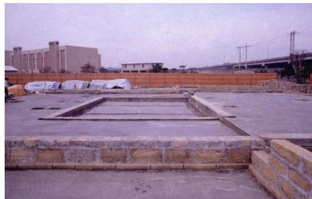
【圖 3-73】臺基鋪設好後，地坪打一層 PC 以使地面基盤穩固。
