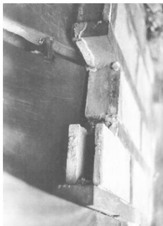
【圖 3-86】林安泰古厝所使用之斗砌磚牆工法，以薄磚砌成盒狀，中央填泥、石粒、磚瓦片之混合物
