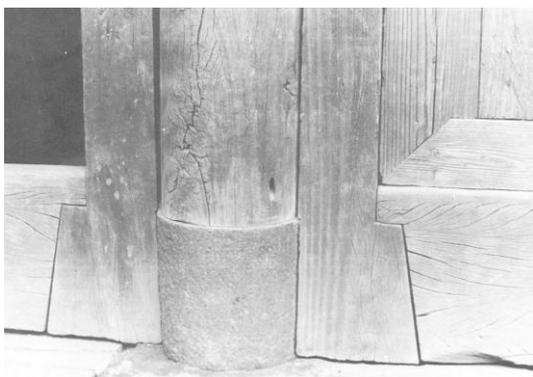
【圖 3-115】門廳木柱以暗楔樁接的方式與石樁及門槌完美接合
