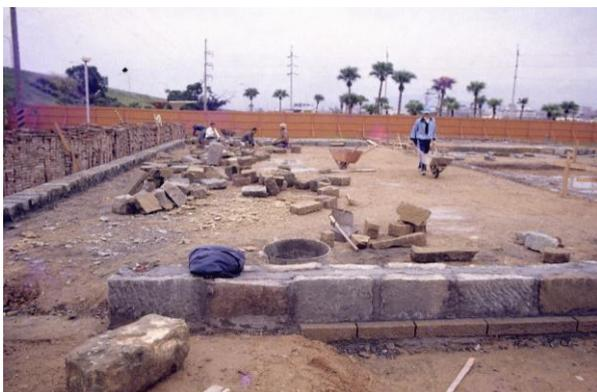
【圖 3-72】風化石主要作為臺基最底層，以隔離水源，保護磚牆。圖中為重建時先鋪設風化石臺基，同時界定整體範圍。
