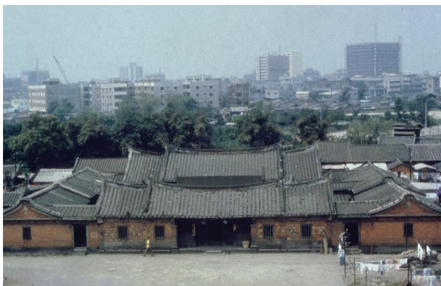
【圖 2-14】林安泰古厝的前埕由紅普石鋪砌而成。 資料來源：重耀建築師事務所提供
