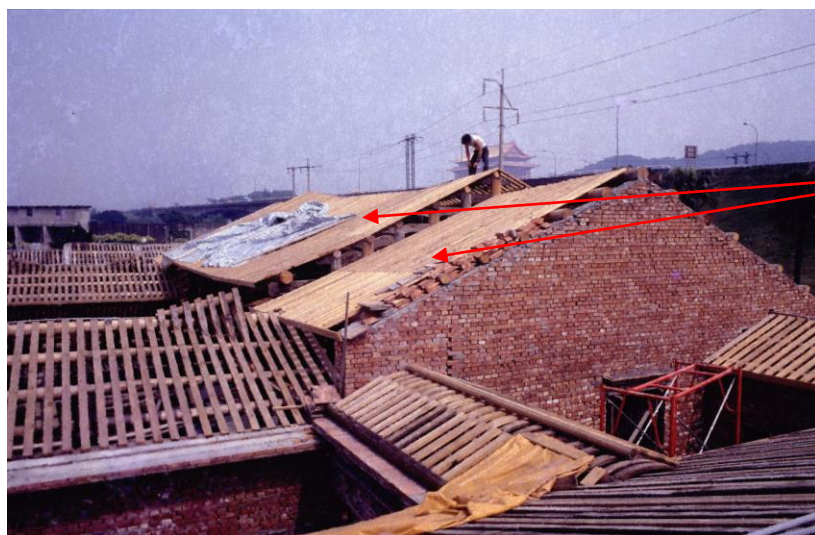
【圖 3-124】「正廳、大房、二房」重組時屋頂椽條之新木料位置 可以發現幾乎全面更新 資料來源：重耀建築師事務所提供
