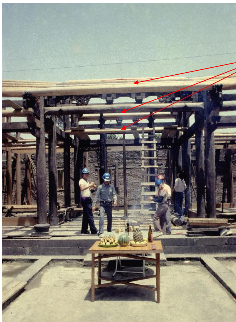
【圖 3-125】「正廳」重組時屋頂桁條之新木料位置 資料來源：重耀建築師事務所提供
