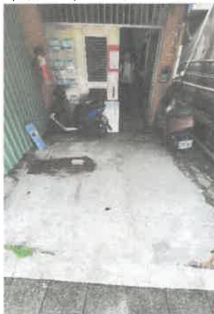
改善計畫及竣工成果：本案高差7公分，設活動斜坡板 W70、L75、S1/9，兩側設突起安全邊緣，水平長度63cm。
