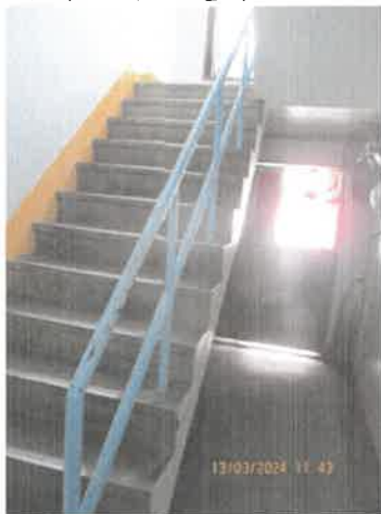
現況：本案有樓梯無電梯
