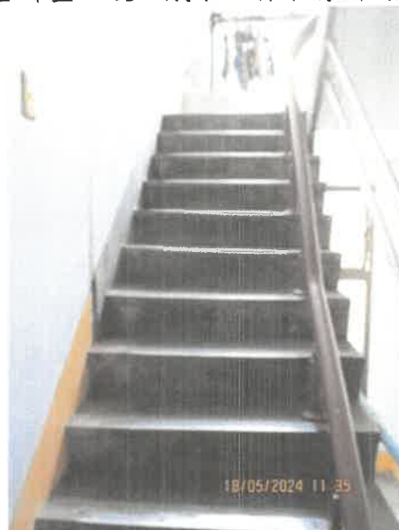
改善計畫及竣工成果：將不銹鋼門拆除
