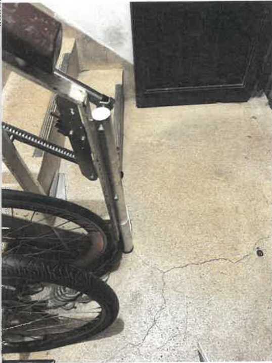
改善計畫及竣工成果：1樓起始端防勾撞處理
