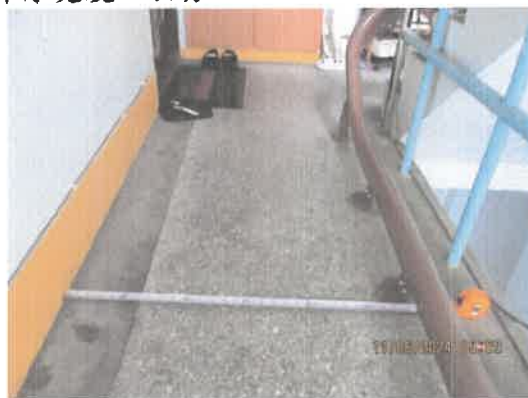
改善計畫及竣工成果：中間平台往2樓階梯淨寬度85公分
