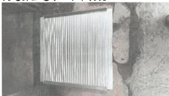
改善計畫及竣工成果：本案高差7公分，設活動斜坡板 W70、L75、S1/9，兩側設突起安全邊緣，水平長度63cm。
