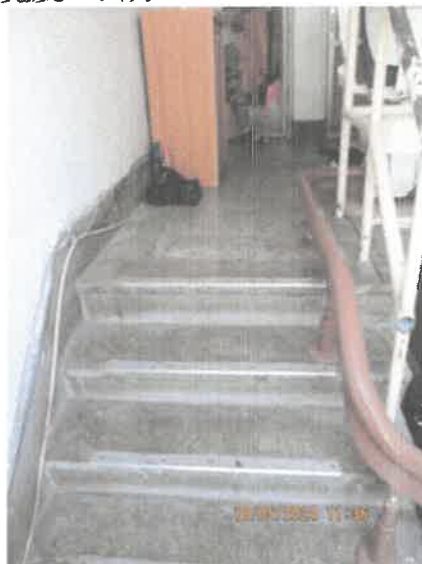
改善計畫及竣工成果：中間平台往2樓階梯淨寬度85公分
