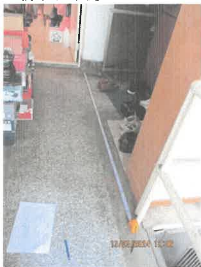
現況：3樓平台深度213m
