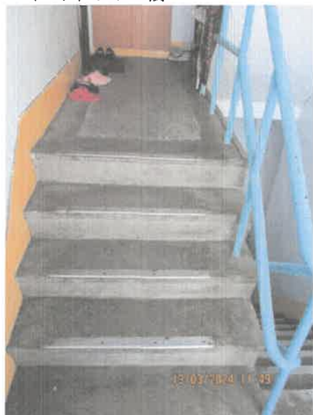
現況：中間平台往2樓
