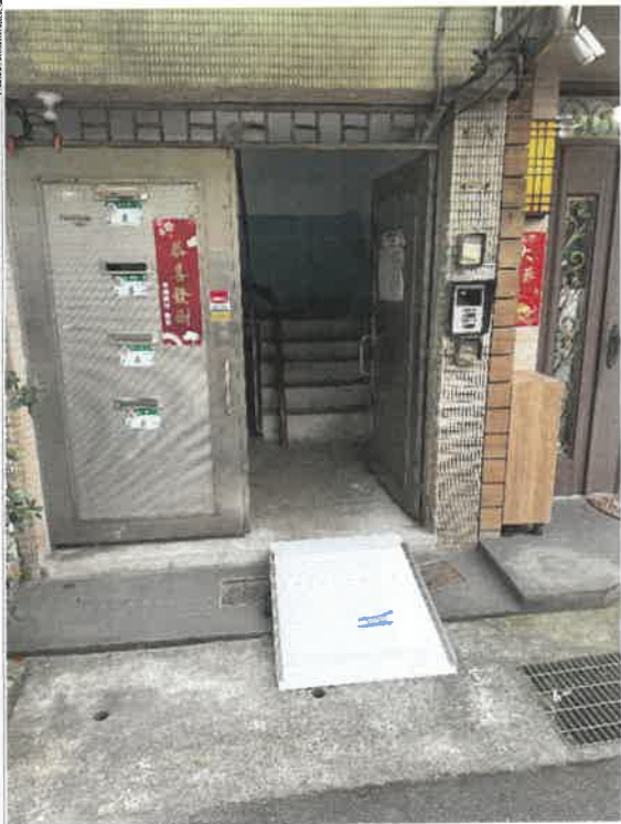
改善計畫及竣工成果：75X91公分單片鋁合金活動式斜坡板，坡度1/6。
