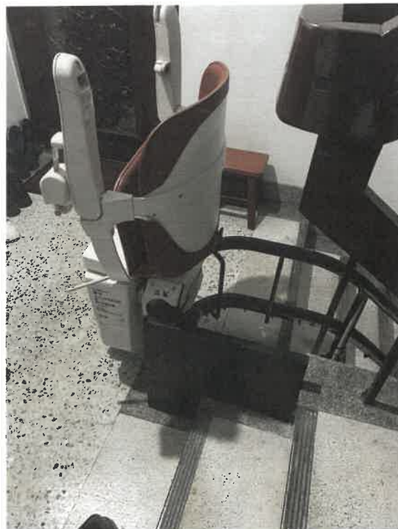
改善計畫及竣工成果：4樓新設樓梯附掛式升降椅防勾撞裝置
