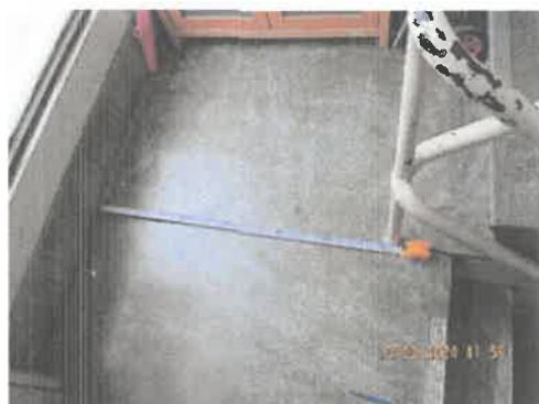
現況：2樓中間平台深度92.5cm
