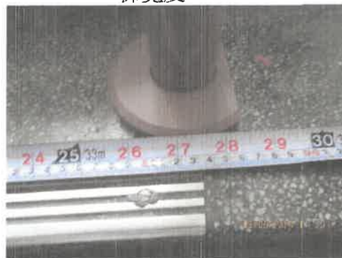
改善計畫及竣工成果：2樓往中間平台階 梯寬度80cm
