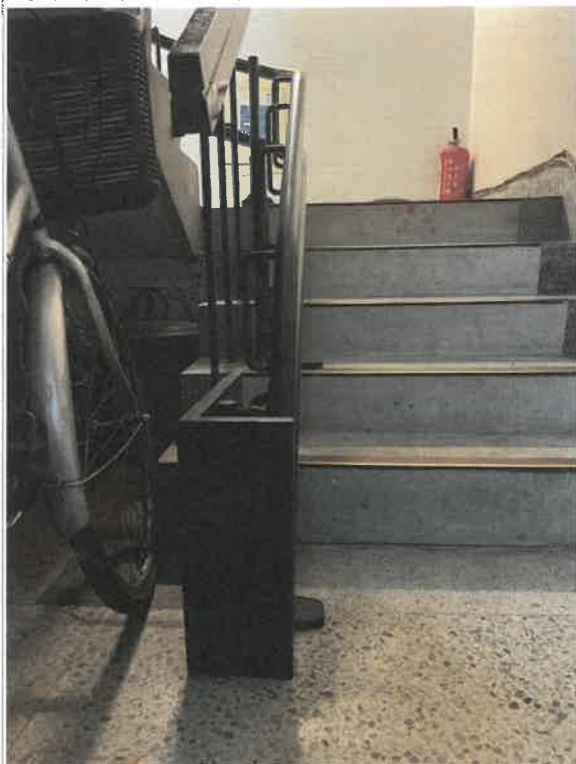
改善計畫及竣工成果：1樓新設樓梯附掛式升降椅防勾撞裝置
