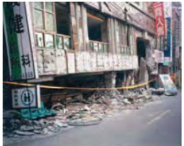
照片 1-4 外牆裝修材
