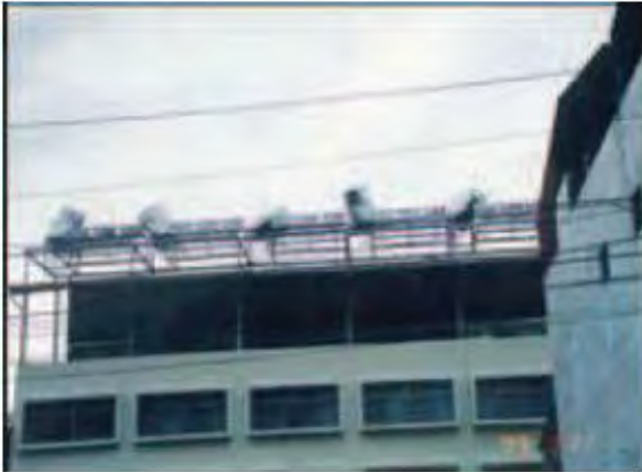
照片1-7 屋頂水塔
