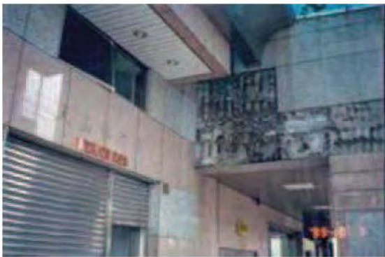
照片1-31 內壁裝修材
