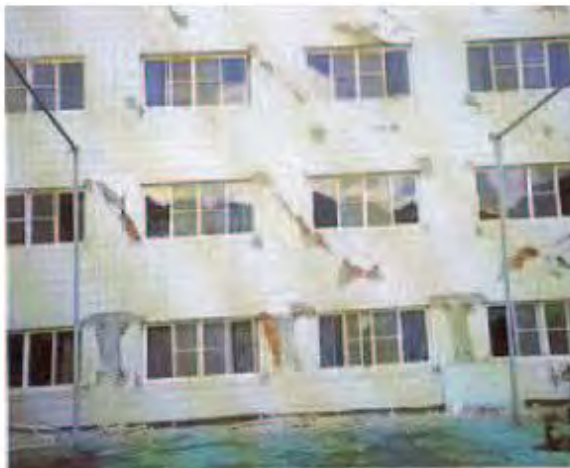
照片 1-3 外牆裝修材
