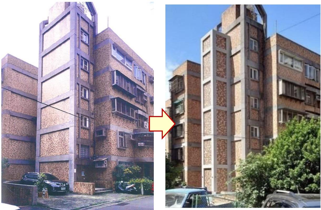
施工過程因為有社區住戶習慣在法定空地停車，導致工程車無法進場灌漿作業，必須先做好施工前的溝通協調，才能順利施工，再加上 RC 構造施工須逐層綁紮鋼筋、封模灌漿，需要較長的施工期程。
