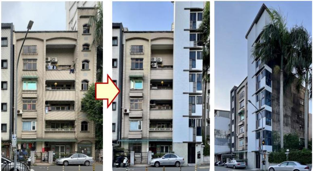
王瑞婷建築師表示，本案建築物臨道路側，與建築線間剩餘深度有限，必須將電梯設備及電梯梯廳配置於基地法定空地內，經多次與電梯設備廠商及結構技師溝通討論後，順利產出建築設計圖說、結構設計圖說及昇降設備圖說。並於 110 年 6 月領得都發局核准增設電梯
