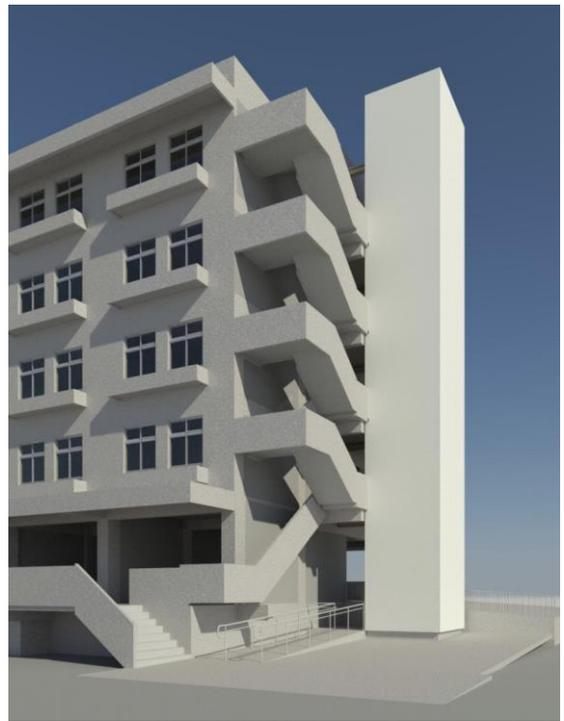
增建電梯塔結構設計著眼於施工性與結構特性，整體構造以鋼構形式為主。在重作鑽探以確認地層承载力、液化潛勢後，判斷若僅靠增設電梯塔本身的結構與基礎，結構上僅能自立與負擔載重，但對於地震力的抵抗的能力上有所疑慮。綜合考慮興建時程與整體成本，因此在結構技師的建議下，在電梯塔構造與既有建築物之間增加繫樑，以拉住既有建築物結構體的方式共同對抗地震力。由於緊靠增建電梯井的既有建物外挑懸臂走廊並無主要樑柱，因此繫樑必須內伸貫穿走廊後錨定於建物本體的大樑，以獲得最佳的結構效果。增建電梯井立面材料採取最實用耐候的彩鋼外牆，相對於混雜的建築物外牆，簡易樸實的電梯井反而形成沉穩而堅固的存在。
