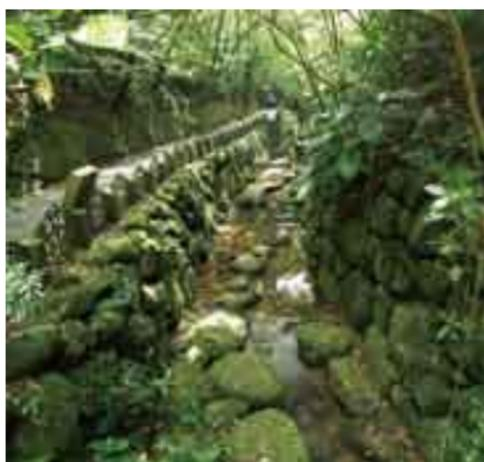
**考**量對自然環境的維護，避免造成景觀破壞，溪溝的結構物表面以自然塊石處理，藉由塊石的天然材質來緩和視覺衝擊，營造視覺上的美感。
