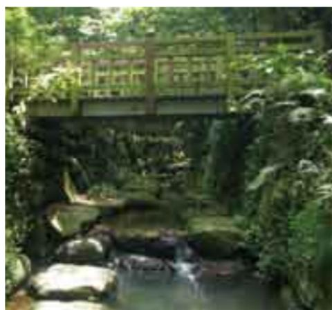
**設**置深潭淺灘製造跌水效果，增加水中含氧量，配合護岸的石縫和拋石，營造有利水中生物生長的棲息環境。
