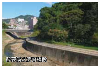
醉夢溪河流三面光的水泥整治
