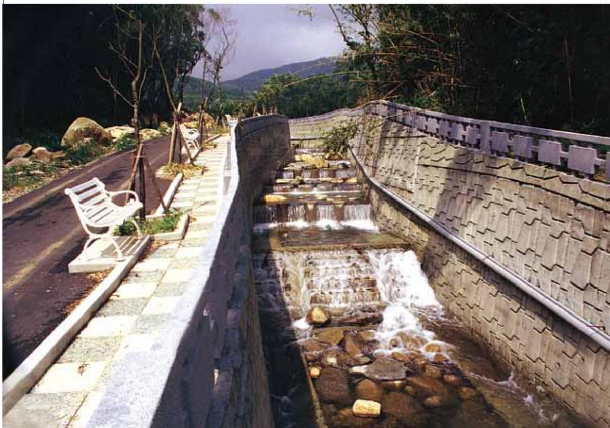
↑不同造型及落差的跌水工，創造出水體的變化，增加水中溶氧量，淨化水質，並可減緩溪床坡降，防止縱、橫向沖刷。
