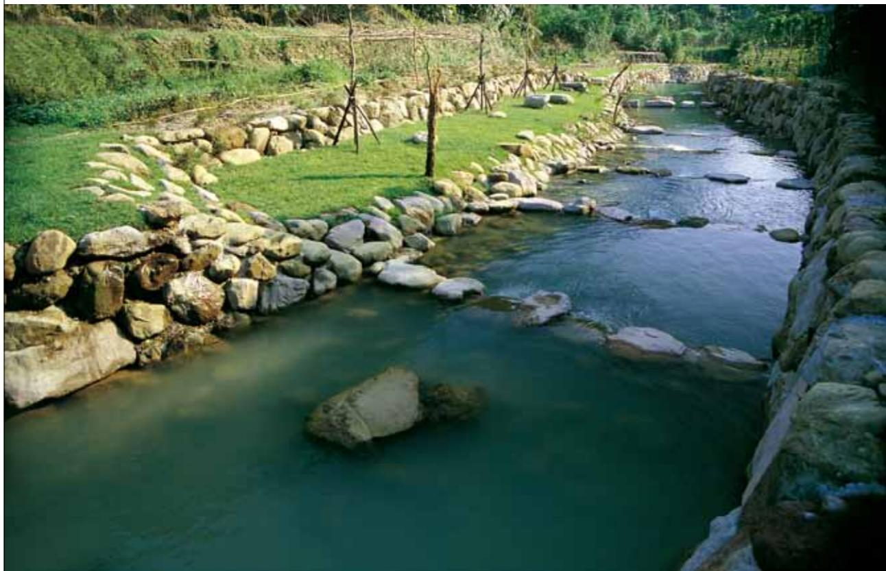
設計小平台，規劃出親水空間，提供草、昆蟲、蛙類等生物的水陸棲息環境。利用溪溝岸邊的原石來設計自然護岸，一來擋洪災，二來避免使用混凝土破壞環境。
