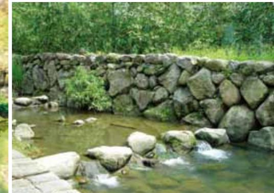
↑ 溪流落差較大處的塊石魚梯，降低流速，維持全段水中生物迴游走道的暢通，提供魚蝦等生物生存繁衍機會。
