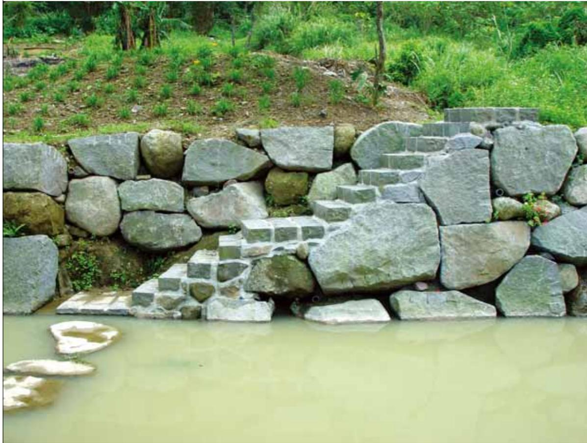
在溪流落差較大的地方，設計塊石魚梯，以有效降低流速，跌水消能、以及防止縱向沖蝕，並且能維持全段水中生物迴游走道的暢通，增加魚蝦等生物在此生存繁衍的機會，為大自然生態復育盡一分心。
