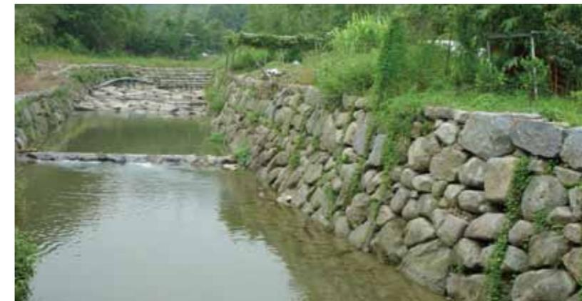
←型框護坡穩定步道基腳，維護沿溪步道的暢通，也達到植生綠化之目的。
