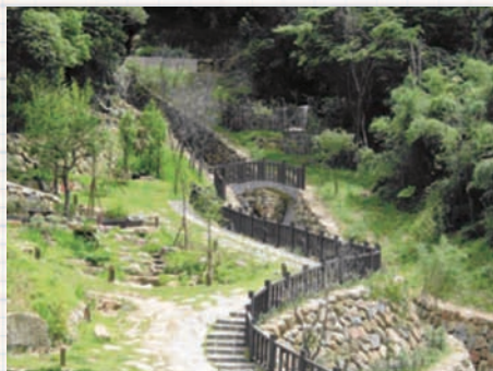
▲ 嚴謹施作態度，完美呈現溪溝整治成效。
