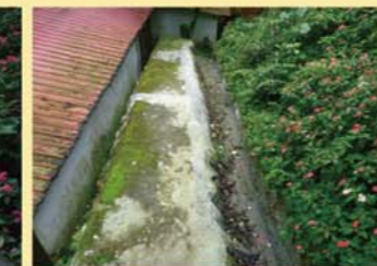
▲排水溝阻塞並修復
