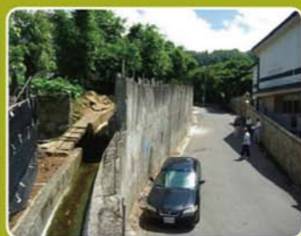
▲人工邊坡傾斜、外凸
