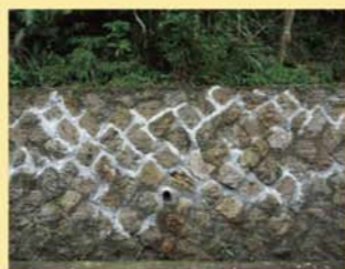
▲填補裂縫後
