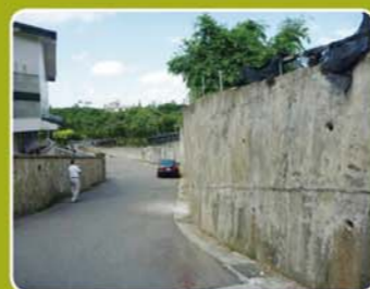
▲人工邊坡傾斜、外凸
