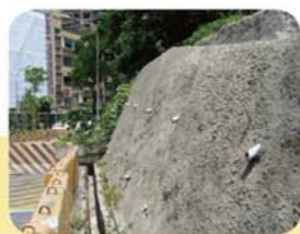
▲噴凝土擋土牆
