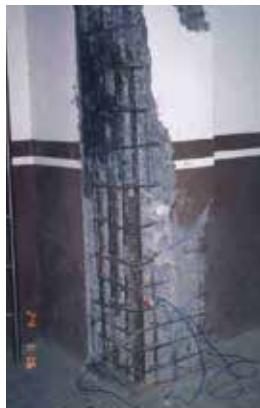
房屋是否為「海砂屋」，可以透過混凝土中之氯離子含量予以檢測。經濟部標準檢驗局早於83年7月修訂的CNS 3090「預拌混凝土」中就有水溶性氯離子最大容許值的規定，並於87年6月第4次修訂，規定鋼筋混凝土構件型式之新拌混凝土氯離子含量試驗不得超過 $0.3\text{kg}/\text{m}^3$ 。購買預售屋或新成屋，可請建商出具書面證明，保證結構體部分的鋼筋混凝土氯離子含量在 $0.3\text{kg}/\text{m}^3$ 以下。
