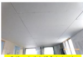
電梯口公共空間處上方隔板
