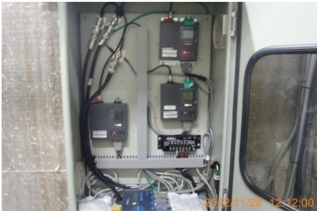
圖 1-2 坡地雨量站及土石流觀測站設備
