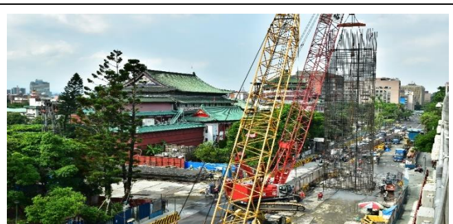
捷運萬大—中和—樹林線(第一期工程) 站體南側連續壁鋼筋籠吊放作業
