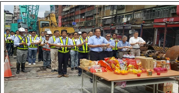
捷運信義線東延段工程 R03 站連續壁施工祈福典禮
