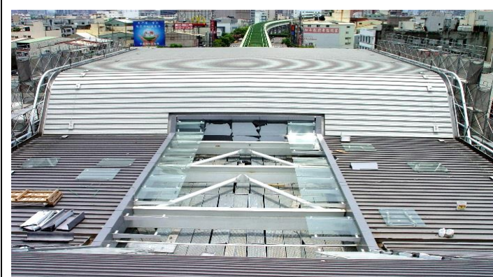
CJ920 標 G08a 站天井收邊及玻璃施工
