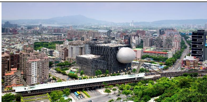
台北藝術中心工程施工現況
