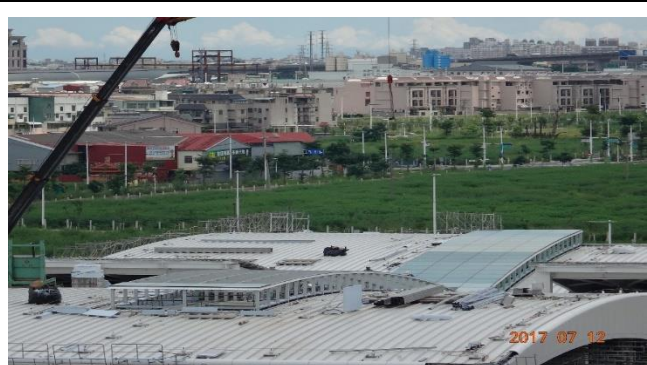
CJ910 標 G0 花崗石地磚/牆面、鋁板、瑛瑯板、景觀花臺、輕隔間、屋頂採光罩、不銹鋼扶手、天花板、植生牆構架施工現況。
