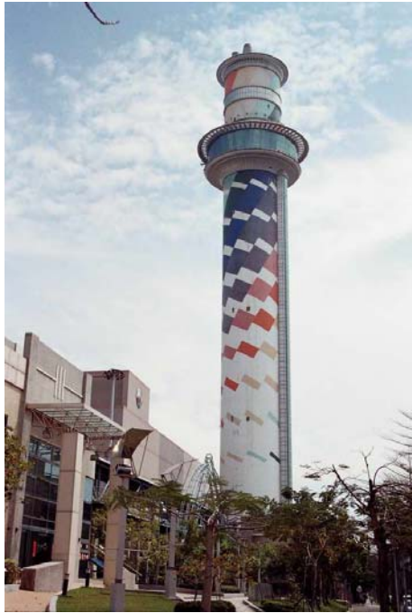
圖 4-27 北投焚化爐煙囪 蕭景文攝
