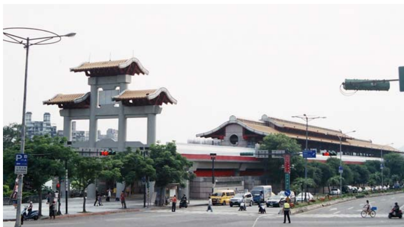
圖 4-20 新北投捷運站
