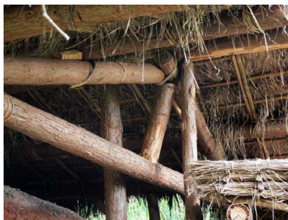
圖 4-13 木炭窯頂部結構
