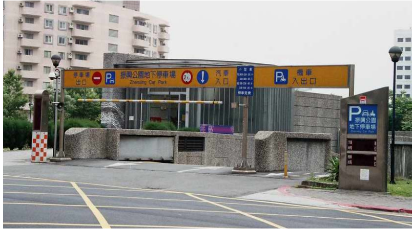
圖 4-23 振興公園地下停車場
