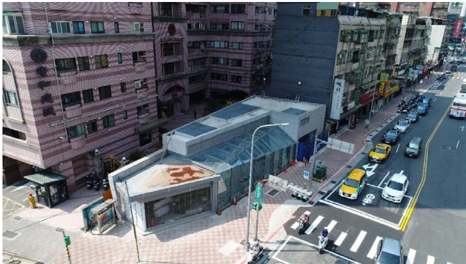
大坪林站(Y6)是環狀線唯一的地下站
