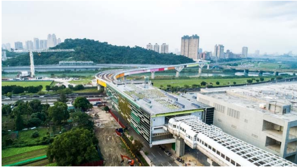
十四張站 Y7 站之設計主題為「大地綠衣」，車站外牆結合垂直綠化、屋頂綠化及綠色坡面連成一道綠色地衣，遠處可看到公共藝術彩虹橋
