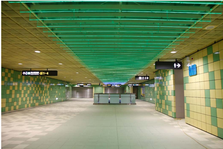
大坪林站(Y6)設計主題：「城市活水·綠巷生活」，室內以塑造一黃色潛水艇為設計發想
