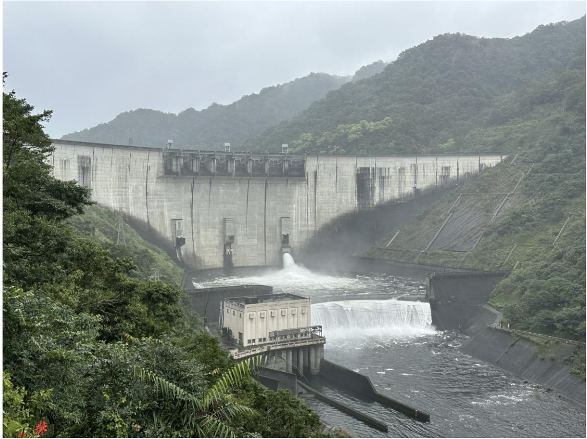
翡翠水庫穩定供水
