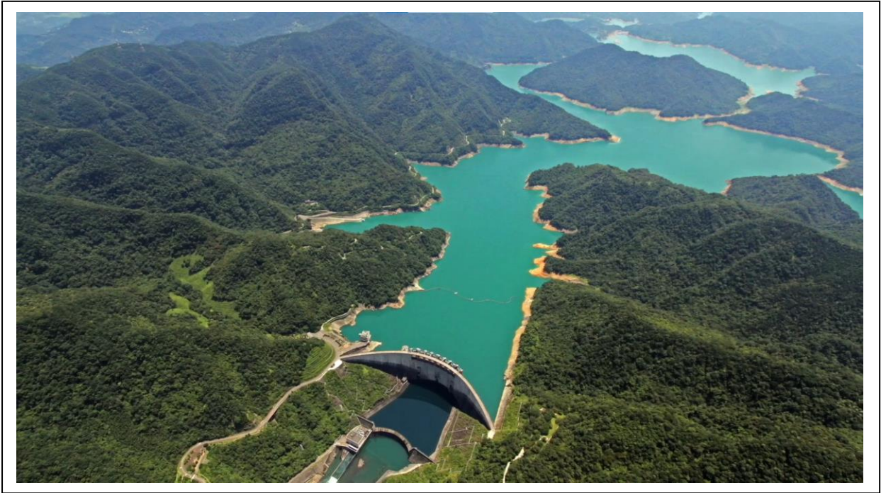
翡翠水庫工程環境-大壩興建，溪流變成水庫
