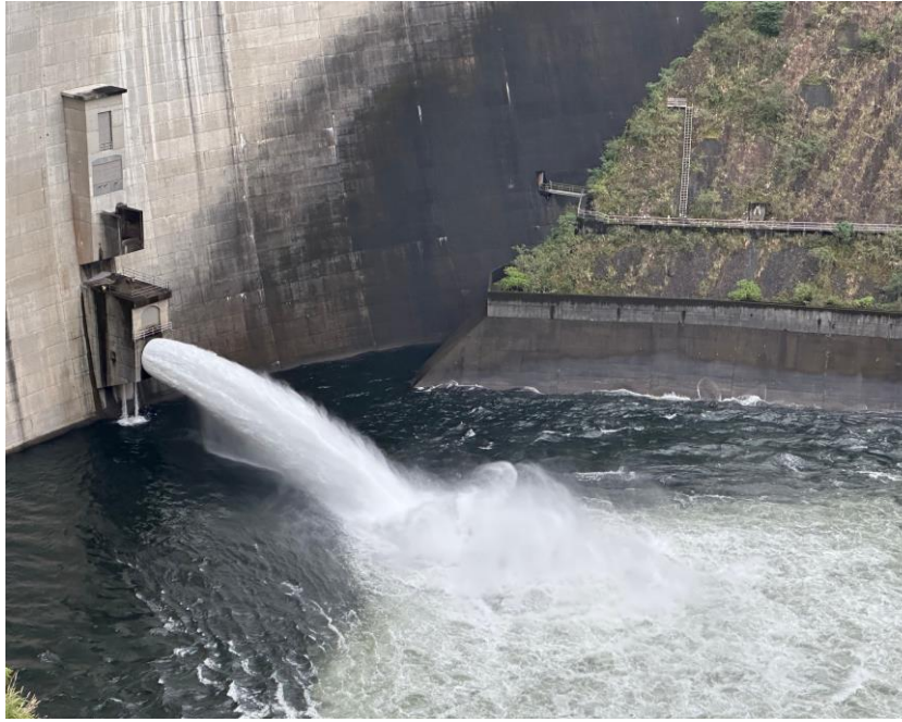
翡翠水庫「蓄清排濁」放水作業
