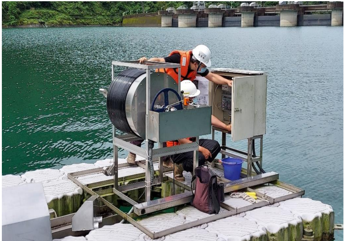
翡翠水庫「分層水質自動監測儀器」定期維護作業
