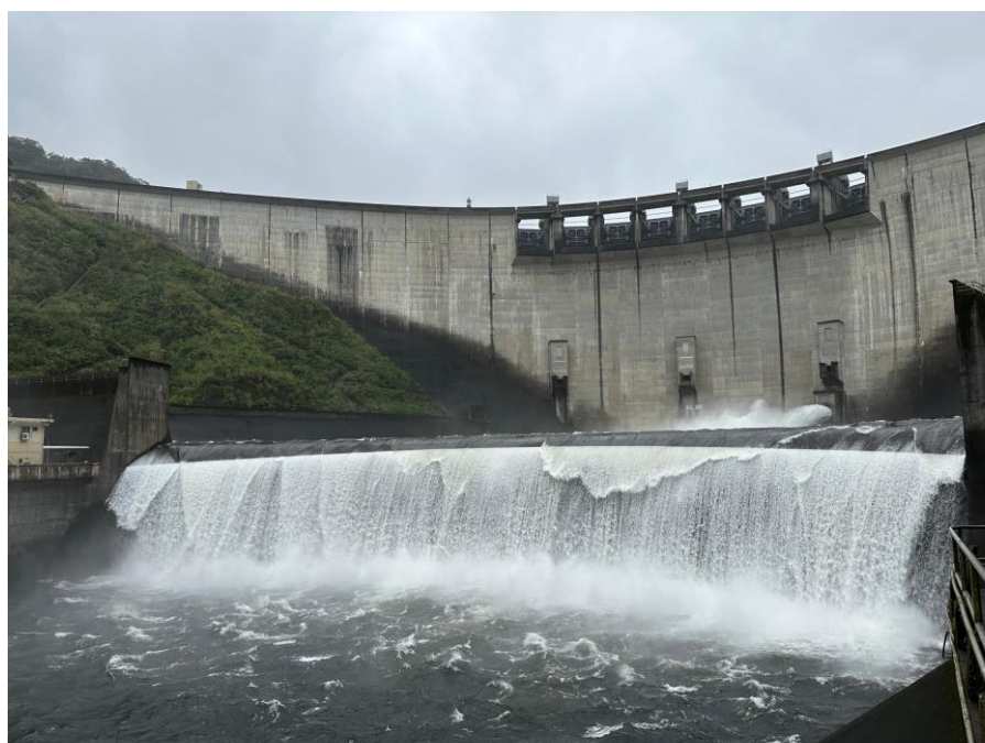
翡翠水庫「蓄清排濁」放水作業
