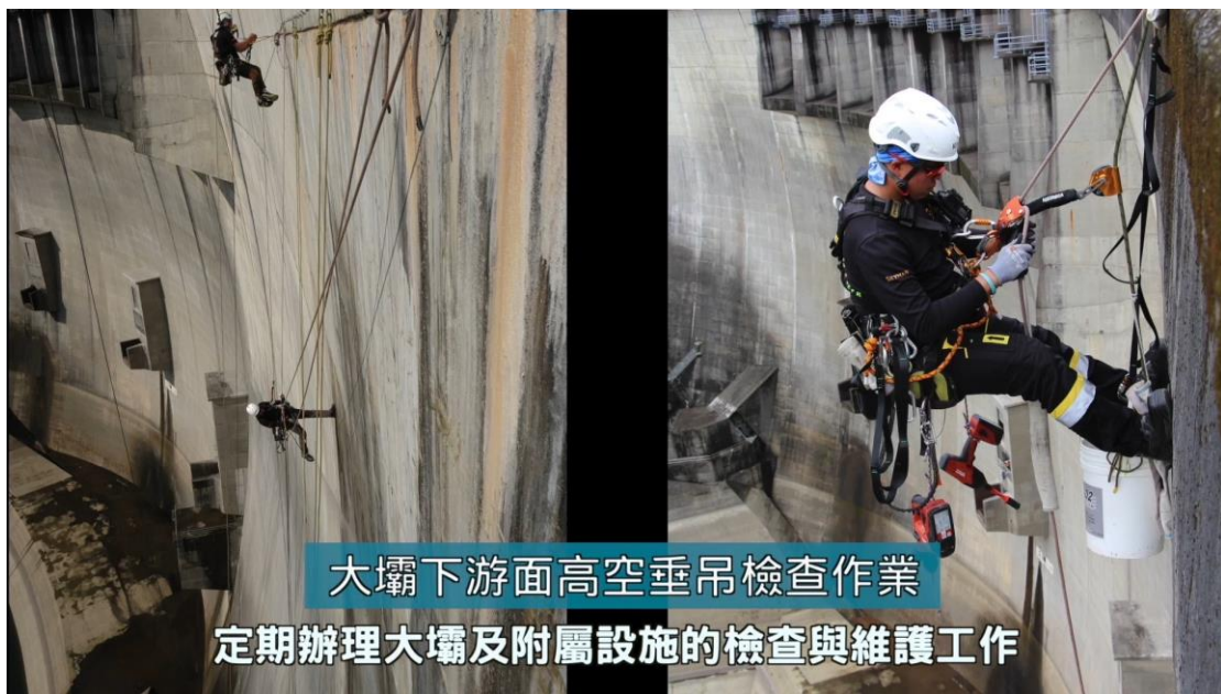
翡翠大壩「蜘蛛人」高空吊掛檢測作業
