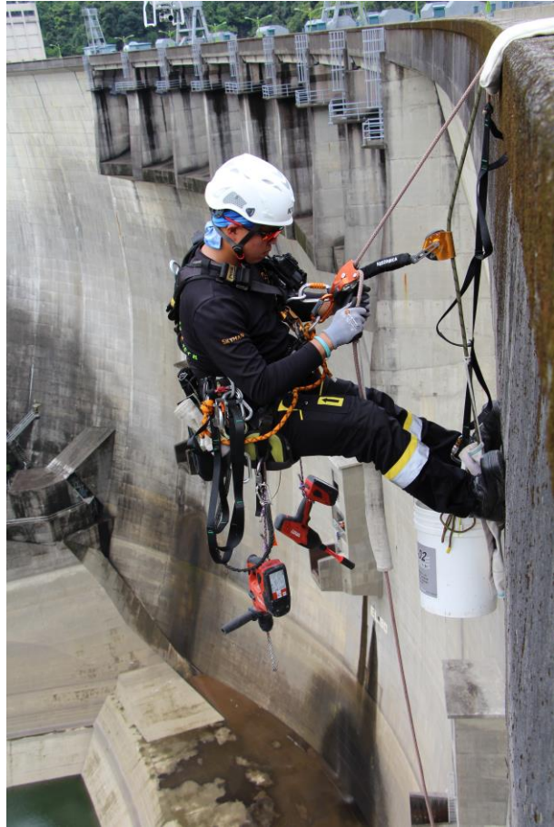
翡翠大壩「蜘蛛人」高空吊掛檢測作業
