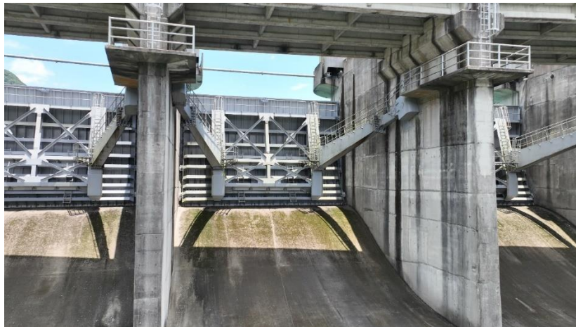
近距離空拍檢視溢洪道結構狀況
