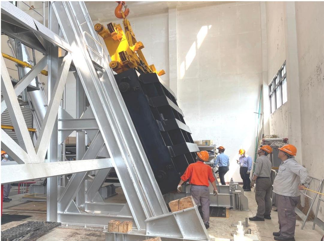
翡翠水庫「排洪隧道」水工機械操作測試
