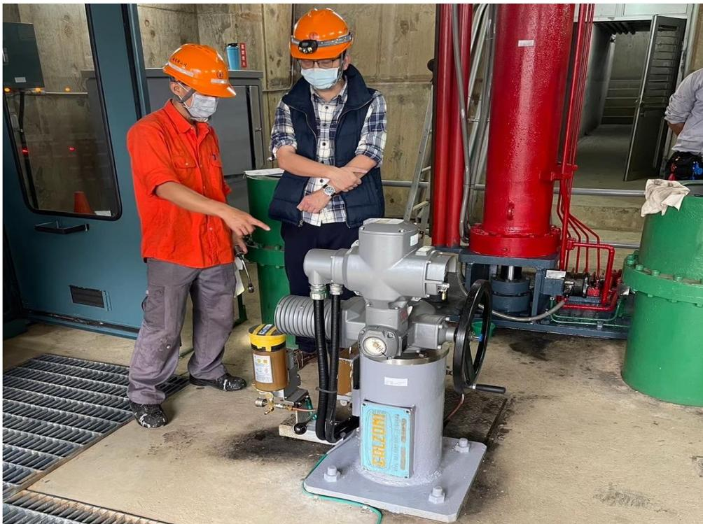
翡翠水庫「河道放水口」水工機械操作測試
