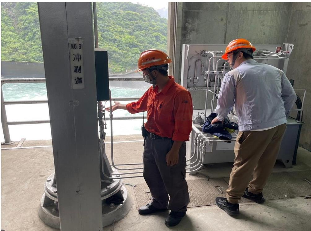
翡翠水庫「沖刷道」水工機械操作測試
