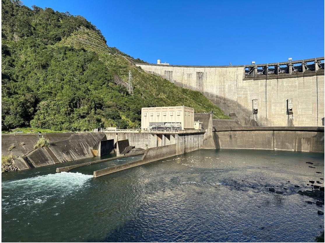
翡翠水庫蓄洪、供水，又兼具水力發電
