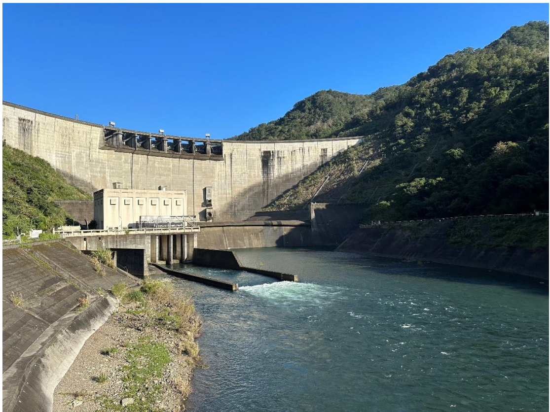
翡翠水庫蓄洪、供水，又兼具水力發電
