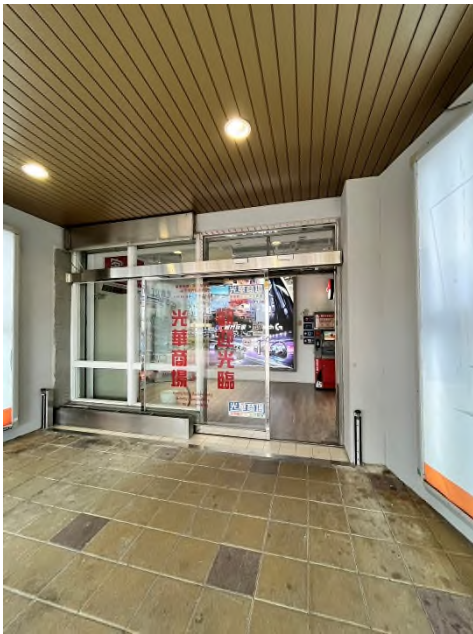
避難層出入口
