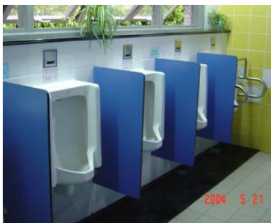
圖 3-32 小便器下方應設置腳踏鋪面
