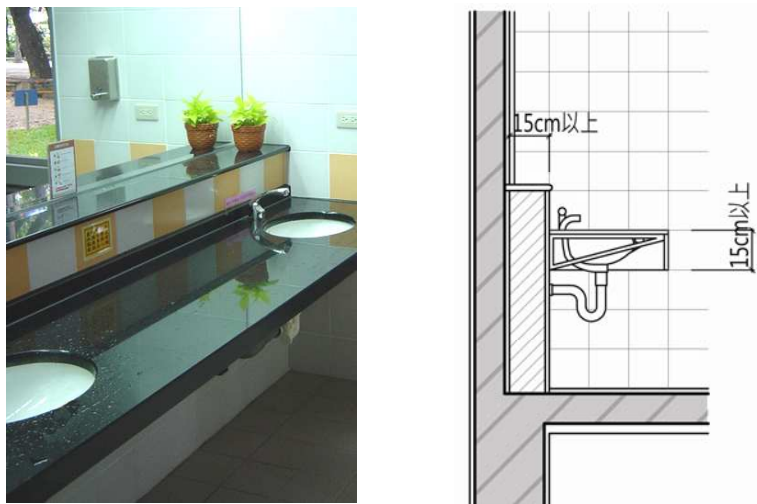
圖 3-41 廁所洗面盆設置案例
