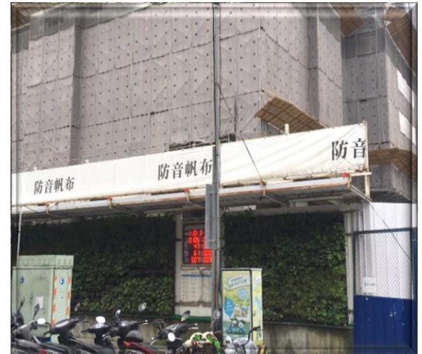
鄰近住宅側圍籬 架設隔音帆布
