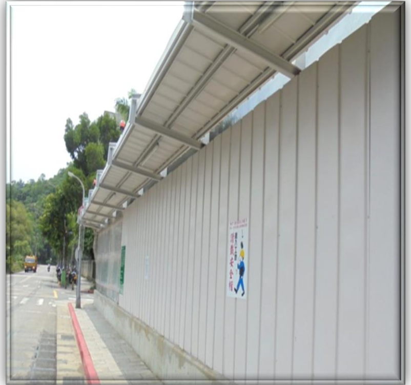
圍籬下方施作防溢座 防止工地排水溢流
