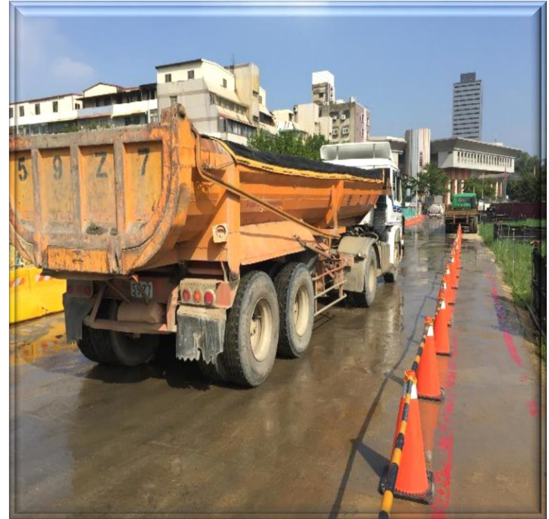
運土車輛防塵網邊緣覆蓋完整
