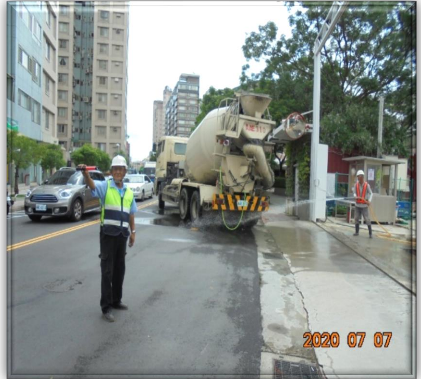
混凝土車輛進出配置交管人員
