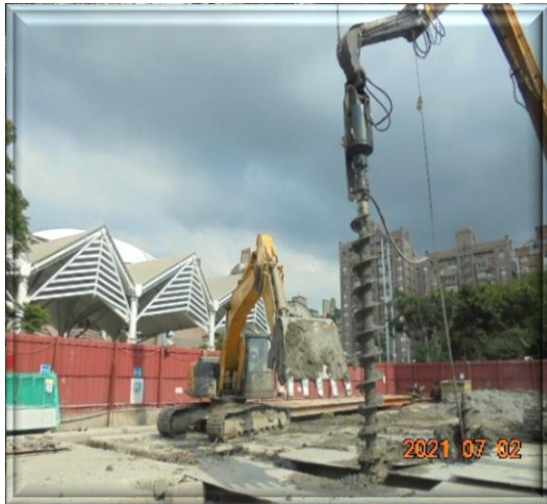
低噪音引孔根固工法
