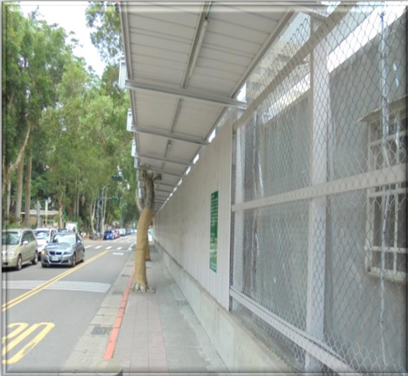
增設安全走廊供行人行走
