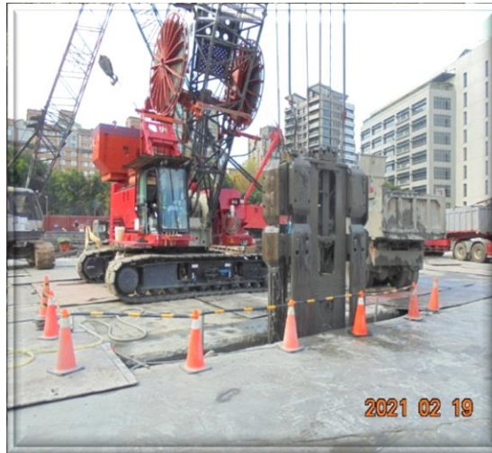
低噪音MHL工法施作
