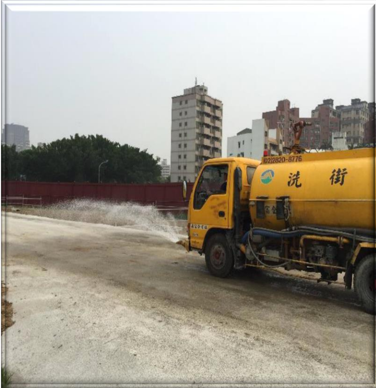
水車施工便道清洗
