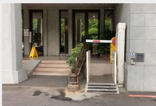
避難層坡道及扶手
